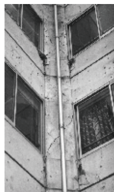
(b) 柱のせん断破壊や損傷 (c) 梁や柱梁接合部の損傷
