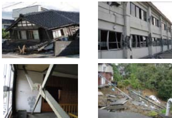
図1 各構造の地震被害例
