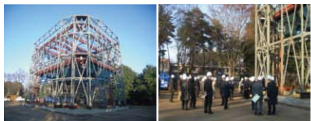
図 5 鉄骨造の実大建物を用いた検証実験
