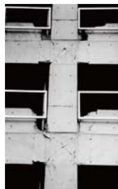
(b) 柱のせん断破壊や損傷 (c) 梁や柱梁接合部の損傷
