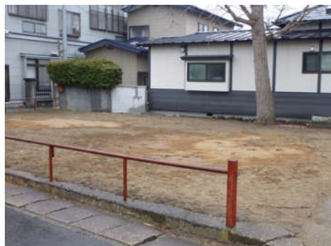
写真 5.2.1-3 液状化による噴砂痕
