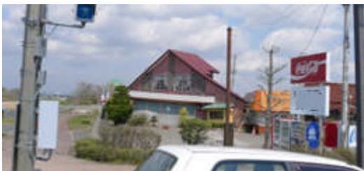
写真 5.2.2-23 地盤変状に伴い傾斜した店舗
