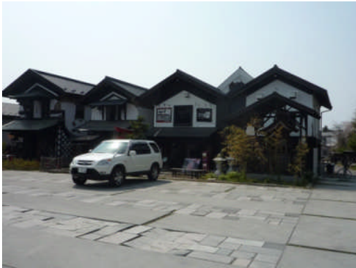
写真 5.2.2-1 大小の被害を受けた土蔵群
