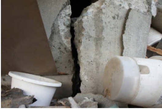
写真 5. 2. 7-25 写真 5. 2. 7-23 の基礎の被害 写真 5. 2. 7-26 写真 5. 2. 7-23 の浴室上部の生物劣化
