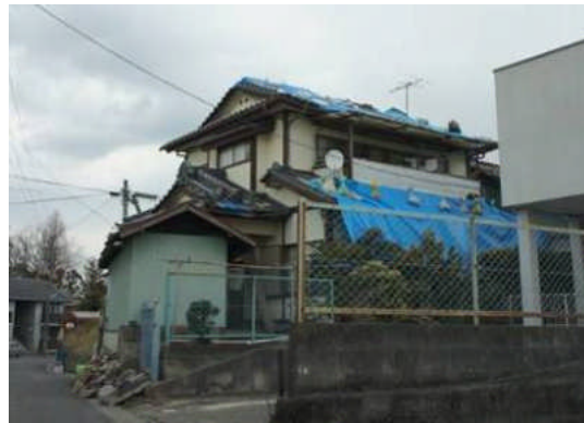
写真 5.2.6-20 屋根瓦の被害
