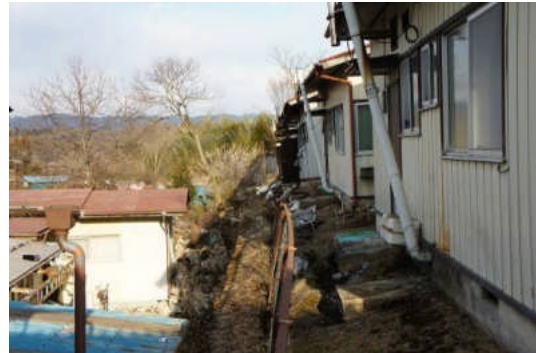
写真 5.2.7-20 写真 5.2.7-19 の立地 (擁壁上部)
