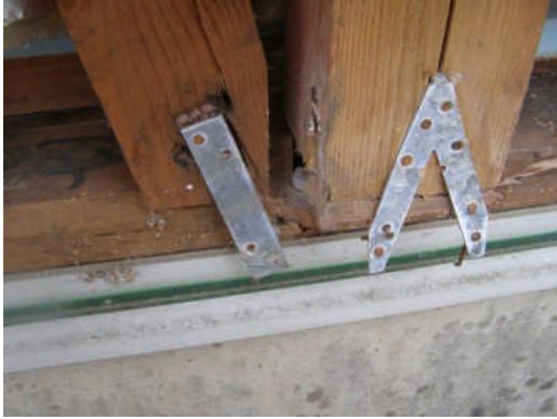
写真 5.2.7-9 写真 5.2.7-8 の柱脚及び筋かい端部
