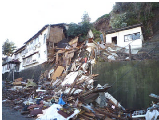
写真 5.2.5-12 旅館の倒壊現場 (仙台市太白区向山)
