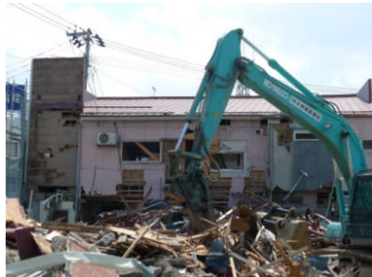
写真 5.2.2-34 解体工事中の木造住宅
