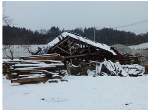
写真 5.2.1-16 木材小屋の倒壊 (栗原市栗駒桜田)
