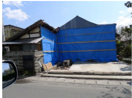
写真 5.2.2-21 前面部分が解体済みの木造
