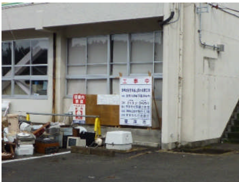
写真 5.2.1-23 瀬峰の震度計設置状況
