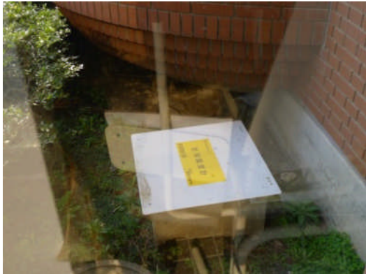
写真5.2.10-12 震度計設置状況(瓜連支所)
