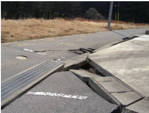
写真 5.2.8-7 路盤の陥没
