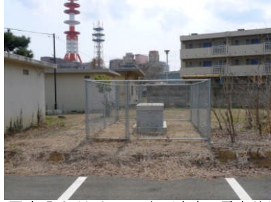
写真 5.2.11-4 JMA 水戸市金町震度計設置 状況
