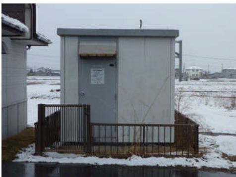
写真 5.2.1-19 栗駒の地震計設置状況
