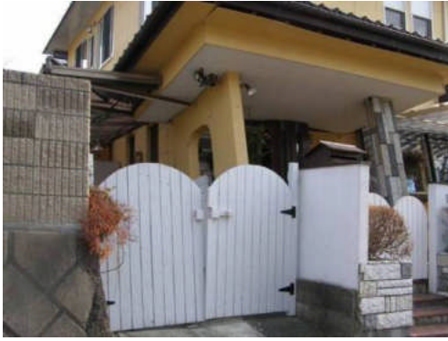
写真 5.2.8-11 地盤変状により大きく傾いた住宅
