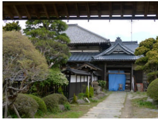
写真 5.2.3-14 残留変形が認められる軸組構法住宅
