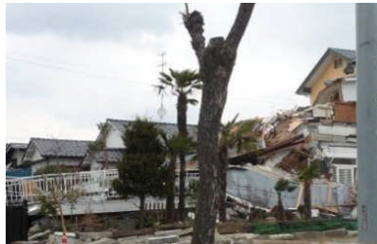
写真 5.2.6-22 倒壊家屋 (構造種別不明)
