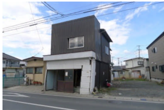
写真 5.2.4-4 傾斜した店舗併用木造住宅
