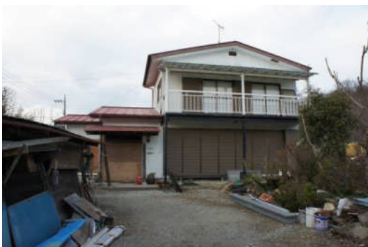
写真 5.2.7-23 大きく損壊した木造住宅 (茶臼地区)
