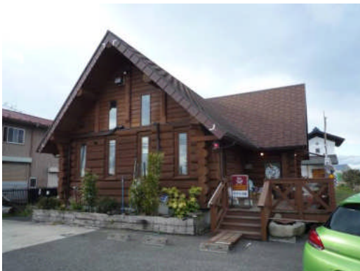
写真 5.2.3-7 外観無被害のログハウス 店舗
