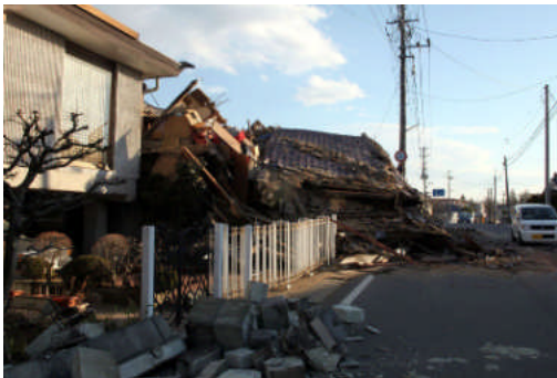
写真 5.2.6-21 南町の倒壊家屋 (須賀川市役所ホームページより)
