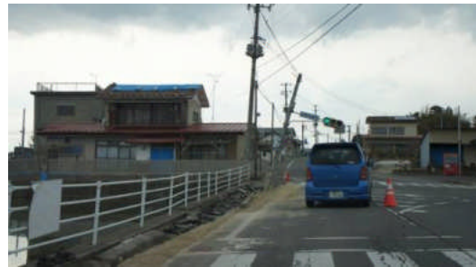
写真 5.2.6-26 傾倒した信号機
