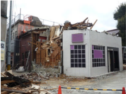
写真 5.2.6-13 大被害と推測される木造
