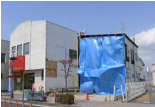
写真 5.2.2-32 取り壊された店舗併用住宅
