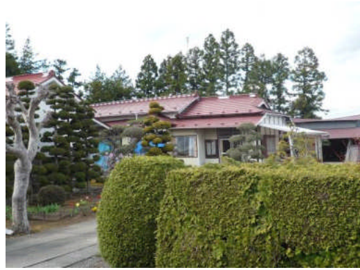
写真 5.2.3-6 残留変形が認められる住宅
