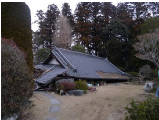
写真 5.2.9-1 1階が完全に崩壊した住宅
