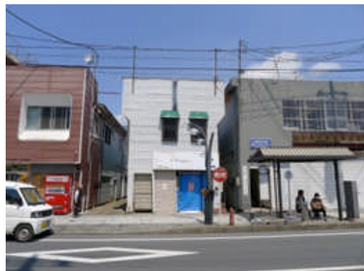
写真 5.2.2-30 傾斜した店舗併用住宅
