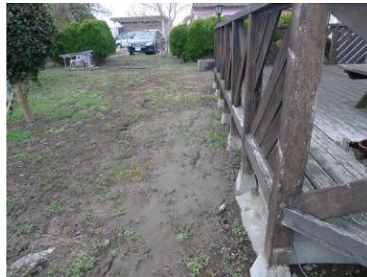
写真 5.2.12-4 液状化による噴砂痕
