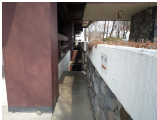
写真 5.2.8-2 震度計の裏のドライエリア
