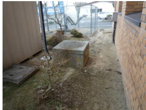
写真 5.2.6-28 震度計設置状況
