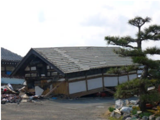
写真 5.2.10-1 倒壊した納屋 (那珂市門部)
