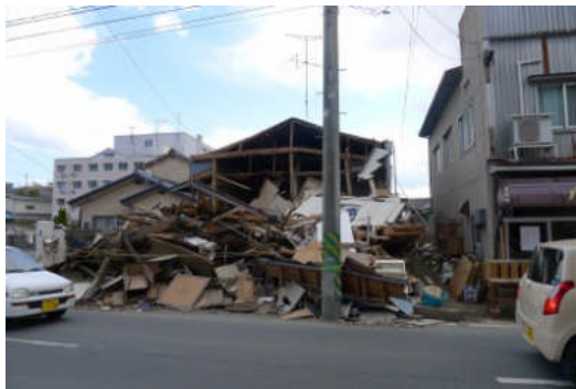
写真 5.2.4-3 倒壊した木造住宅
