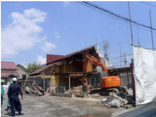
写真 5.2.2-33 解体工事中の木造住宅
