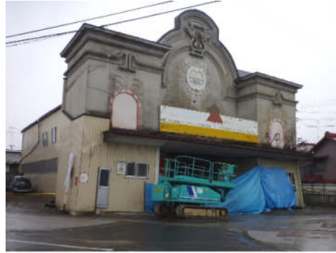
写真 5.2.1-10 古い映画館を改装した工場
