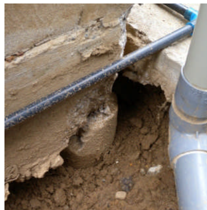
写真 5.5.2.1-12 建物角部の支持構造物
