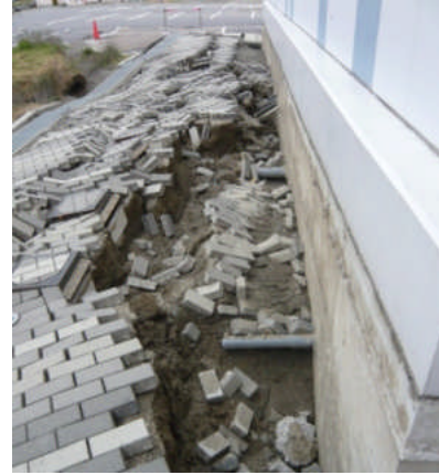
写真 5.5.2.1-21 建築物周囲地盤の状況
