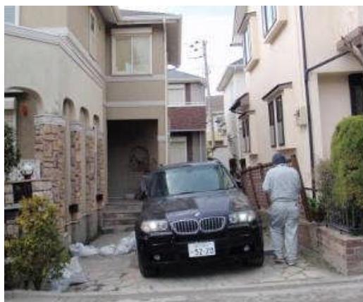
写真 5.5.2.2-10 傾斜した住宅
