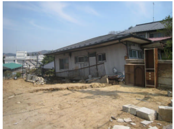
写真 5.5.2.3-6 宅地盛土の滑動・地盤変状による住宅（平屋）の大変形
