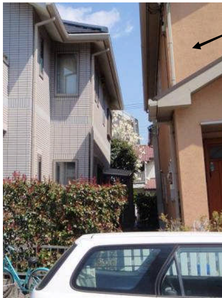
写真 5.5.2.2-5 沈下・傾斜した住宅
