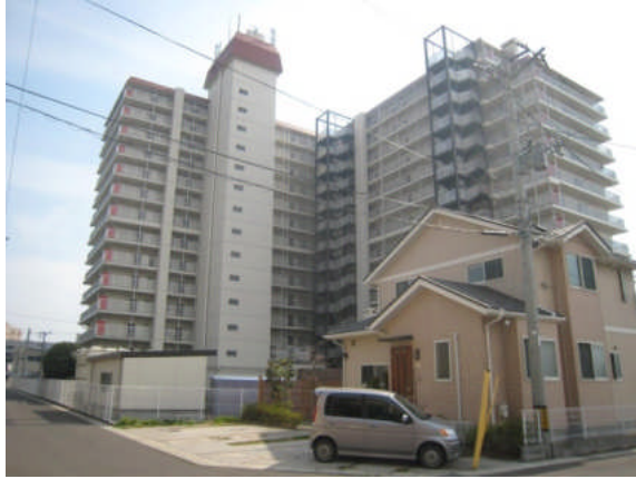
写真 5.5.2.3-23 建物 A の全景 (左側の棟が紙面左奥方向に傾斜)
