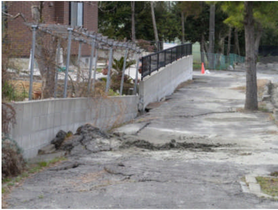
写真 5.5.2.1-27 歩道部分の沈下に伴う塀の被害 写真 5.5.2.1-28 歩道脇の埋設配管の浮き上がり
