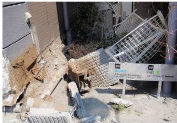
建物間の状況
