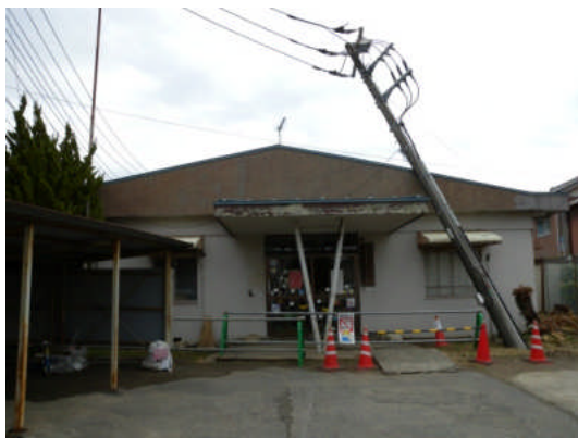
写真 5.5.2.1-3 保健センター入口付近の状況
