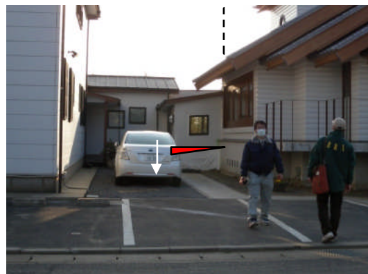
写真 5.5.2.1-36 接続部分の損傷及び駐車場
