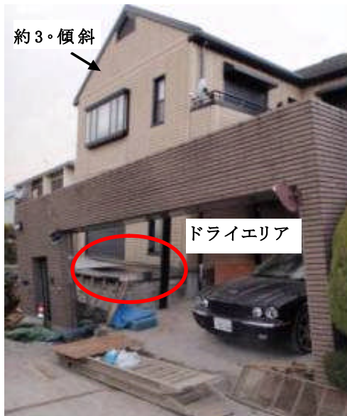
写真 5.5.2.2-1 傾斜した住宅
