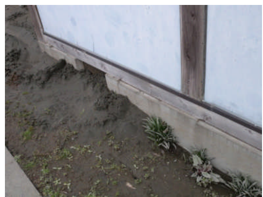
写真 5.5.2.1-32 基礎部分の外観（2）
