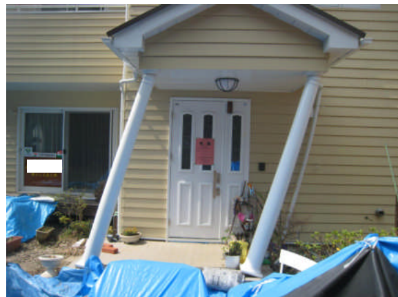
写真 5.5.2.3-2 宅地盛土の滑動・地盤変状の差異により生じた門柱の傾斜
