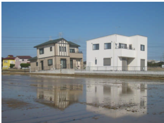
写真 5.5.2.1-43 液状化による宅地盛土および戸建て住宅の沈下・傾斜と盛土擁壁の破壊
