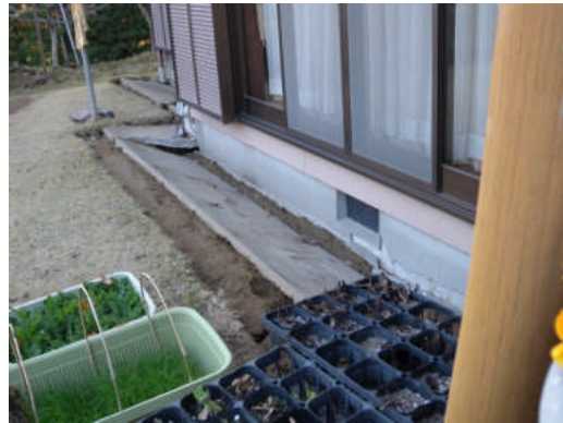
写真 5.5.2.1-38 基礎部分外観
