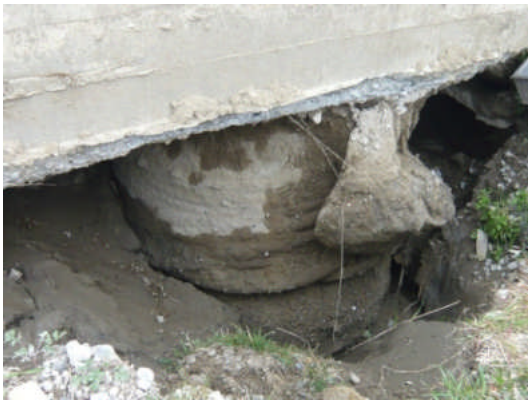
写真 5.5.2.1-22 杭頭部の露出状況
