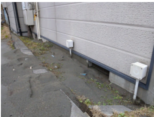
写真 5.5.2.1-31 基礎部分の外観（1）
