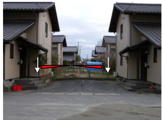
写真 5.5.2.1-30 空地为挟んだ2棟の沈下
