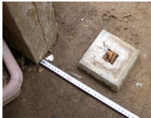
写真 5.5.2.1-10 物置柱脚の移動
