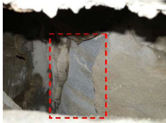
写真 5.5.2.1-23 杭周固定液の内部
