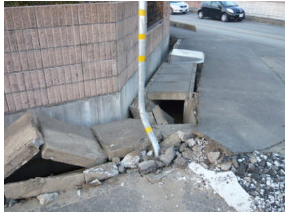
写真 5.5.2.1-40 側溝の被害
