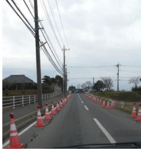
写真 5.5.2.1-2 路盤の亀裂
