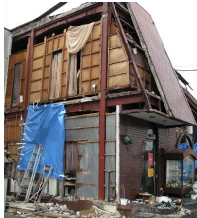
写真 5. 6-6 (左) 写真 5. 6-7 (右) ALC パネルの脱落被害
