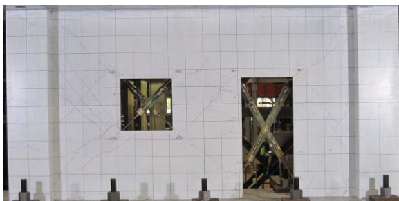
(a) 1/800rad. 加力終了時 (最大ひび割れ幅 →ピーク時 : 0.4mm、除荷時 : 0.1mm)
