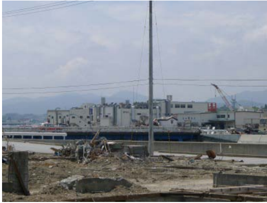
写真 C-14.1 本浜町の海岸側に建つ工場群
