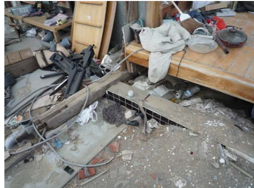
写真 C-12.14 増築部分の土台
