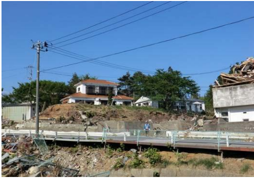
写真 C-7.27 写真 C-7.25 の事務所建築物よりも高台に建つ木造住宅
