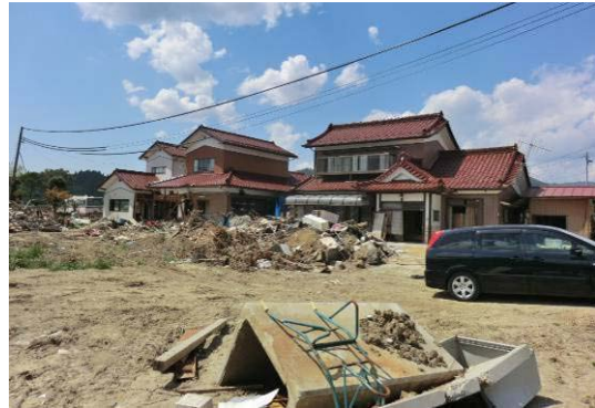
写真 C-7.13 残存する木造住宅 (本吉町津谷新明戸)
