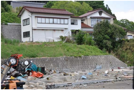
写真 C-7.10 残存する木造住宅 (本吉町二十一浜)
