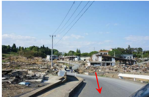
写真 C-7.26 写真 C-7.25 の奥に位置し、津波により大きな被害を受けた S 造の事務所建築物
