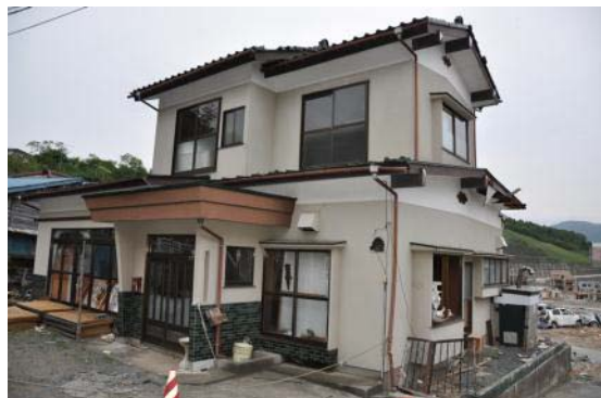
写真 C-13. 28 桜ヶ丘の浸水した住宅
