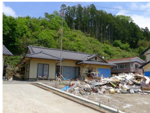
写真 C-14.6 残存する木造住宅
