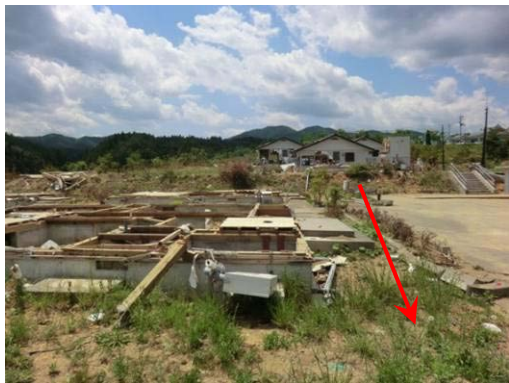
写真 C-7.8 市営住宅 (注) 手前 (海に近い側) が流失し、奥 (海から遠い側) が残存。
