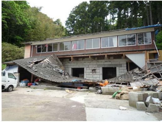
写真 C-20.15 下屋が崩壊した作業小屋 (⑪)
