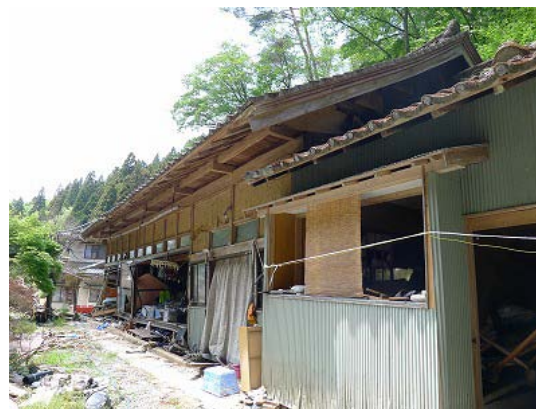
写真 C-15.2 住宅Aの外観
