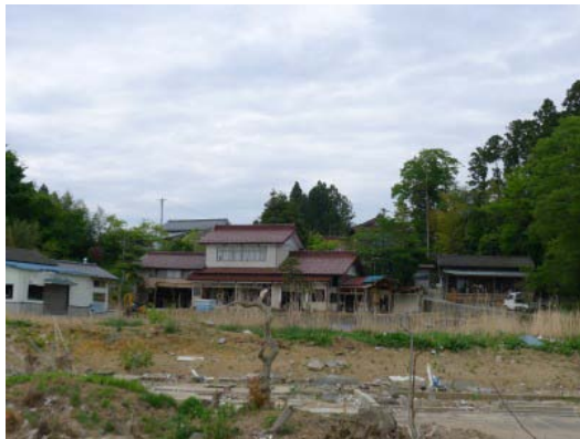
写真 C-18.1 坂の途中で残存する木造住宅
