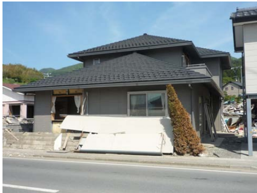
写真 C-10.13 浸水深 5m に対して残存した軽量鉄骨造住宅（浸水深 5 m）
