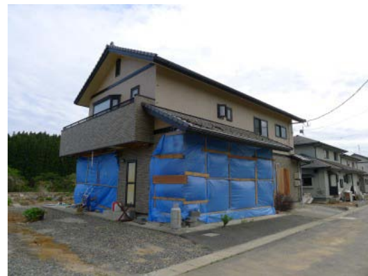
写真 C-17.4 残存する木造住宅
