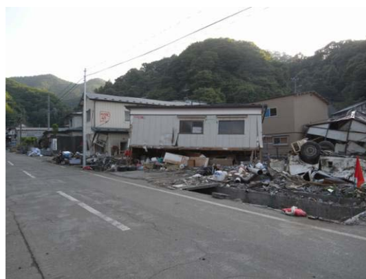
写真 C-5.2 流失境界付近の被害状況
