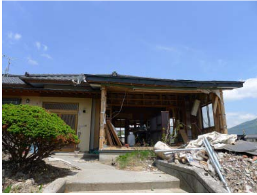
写真 C-8.5 写真 C-8.4 の建物の開口
