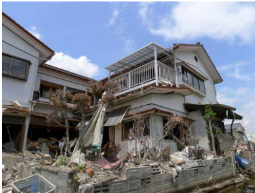
写真 C-14.3 残存する木造住宅
