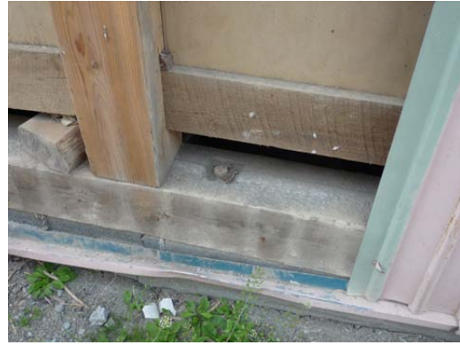
写真 C-10.16 写真 C-10.14 のアンカーボルト
