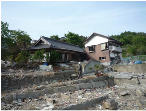
写真 C-12.11 移動して2階建て住宅に衝突
