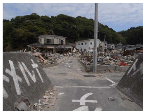
写真 C-20.2 防潮堤の通路から見た大浜地区
