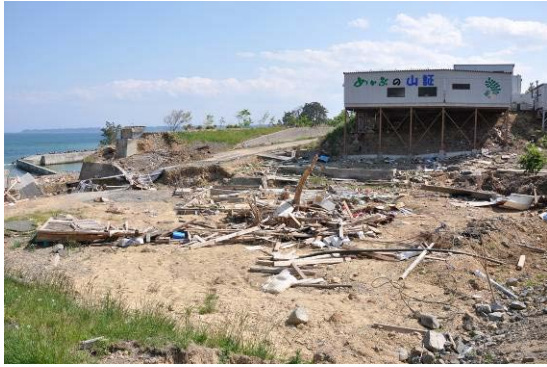
写真 C-7.16 流失した河口付近の木造住宅 (本吉町幸土地区)
