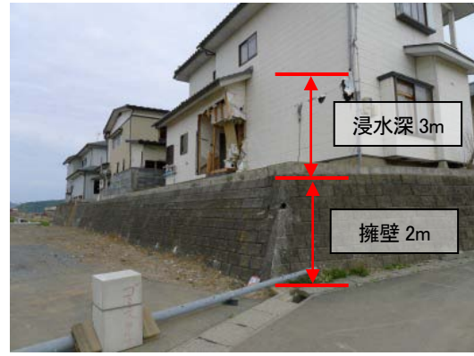
写真 C-17.2 擁壁と浸水深
