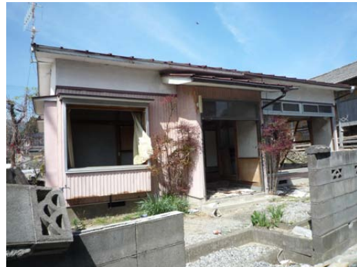
写真 C-10.14 比較的軽微な構造仕様で残留した木造住宅（浸水深 5 m）
