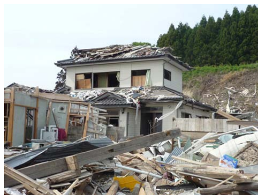
写真 C-11.2 完全に水没しながらも、流失を免れた木造住宅
