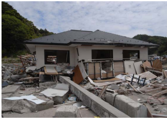
写真 C-20.17 流された軽量鉄骨造 (⑬)
