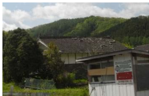
写真 C-1.2 棟瓦の被害
