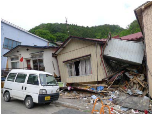
写真 C-4.1 倒壊した木造住宅
