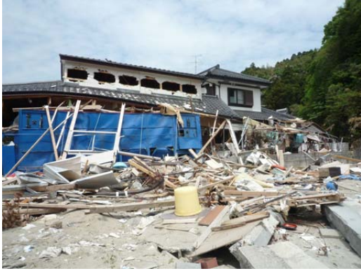
写真 C-20.3 機械にもたれて残存する木造(①)
