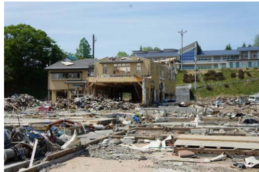
写真 C-13. 8 清水浜駅周辺の流失木造住宅
