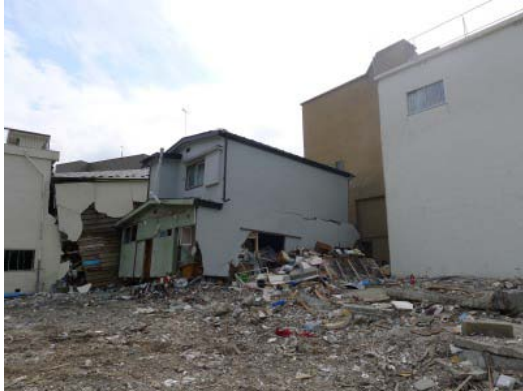
写真 C-4.5 1F 柱脚部が崩壊した木造住宅
