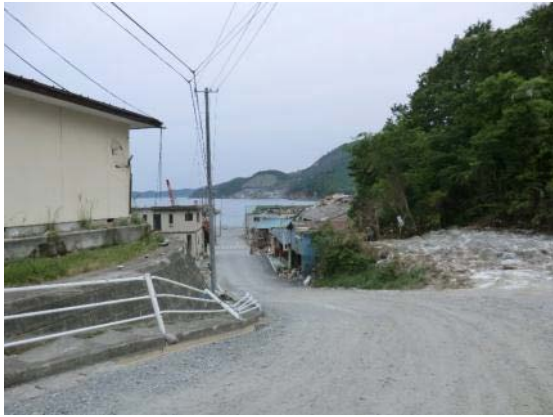
写真 C-13. 22 宮ヶ崎宮ヶ崎の傾斜路面
