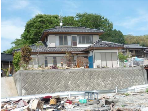
写真 C-10.9 赤碓町海岸付近で流失を免れた木造家屋（浸水深 6 m 以上）
