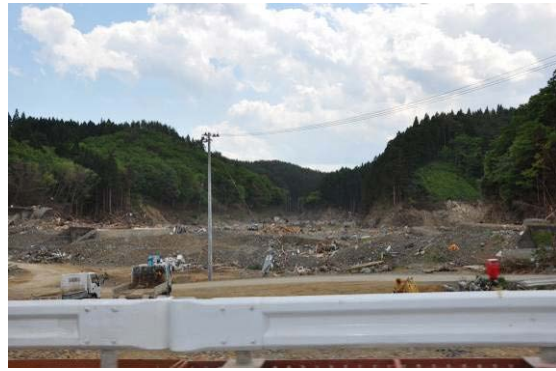
写真 C-7.11 流失した木造住宅(本吉町二十一浜)
