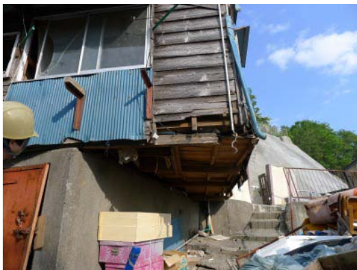
写真 C-4.13 前写真の建物の基礎上端部
