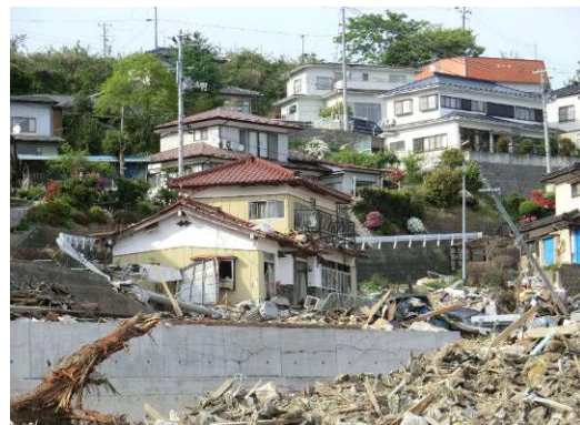
写真 C-13.13 中央の木造住宅は2階開口部上部まで浸水
