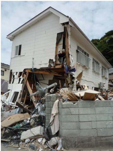
写真 C-20.7 傾きながらも残存する木造 (⑤)
