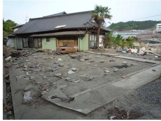
写真 C-12.10 数メートル移動した平屋の家屋
