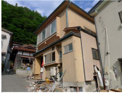
写真 C-4.10 基礎上端で移動した木造住宅
