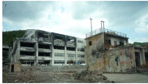
写真 C-2.2 火災が発生した大槌町中心部
