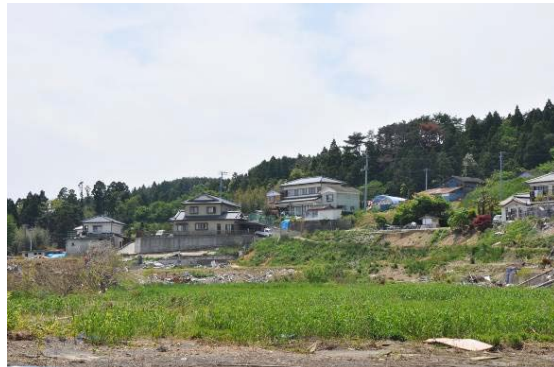
写真 C-13. 6 歌津馬場地区の残存木造住宅
