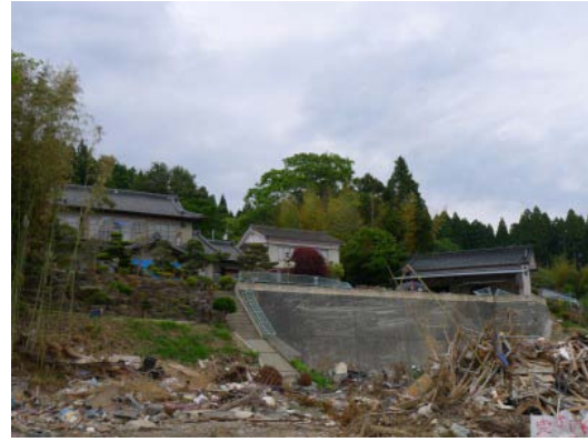
写真 C-16.2 擁壁の上の木造住宅
