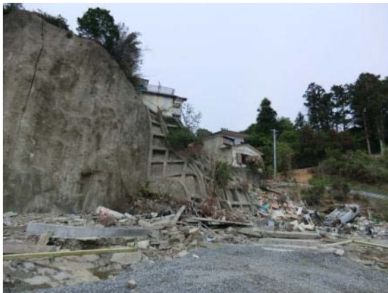
写真 C-13. 20 宮ヶ崎川尻の住宅被害
