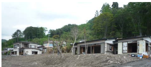
写真 C-2.11 第 2 列目くらいの高さの残存木造住宅 (右 : ①、左 : ②)
