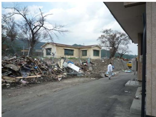
写真 C-2.7 第 14 地割南東部に残るポンプ小屋 (②)
