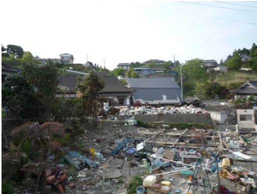
写真 C-12.5 流失、転倒などの被害
