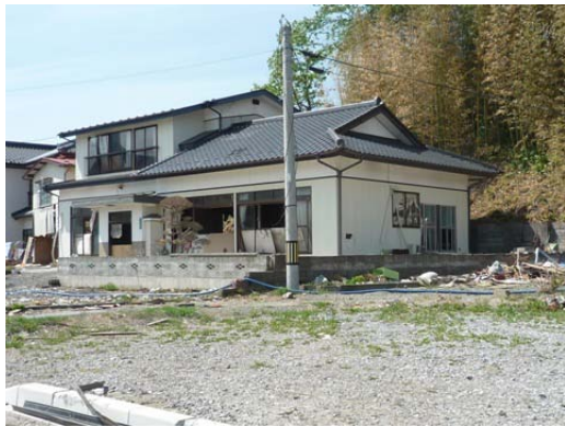
写真 C-10.5 赤碕町海岸付近で流失を免れた 木造家屋 (浸水深 7 m 以上)
