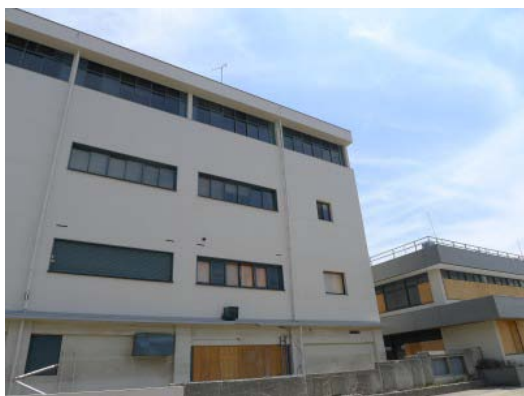
写真 C-8.1 15.4m の浸水深で残存した RC 造
