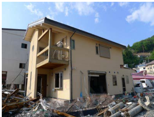
写真 C-4.14 残存した木造住宅
