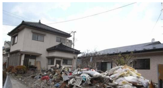
写真 C-2.8 ポンプ小屋の入射方向と反対方向に残る木造家屋 (③ : 左、④ : 右)
