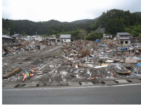
写真 C-3.2 傾斜地手前の流失家屋と奥の非流失家屋
