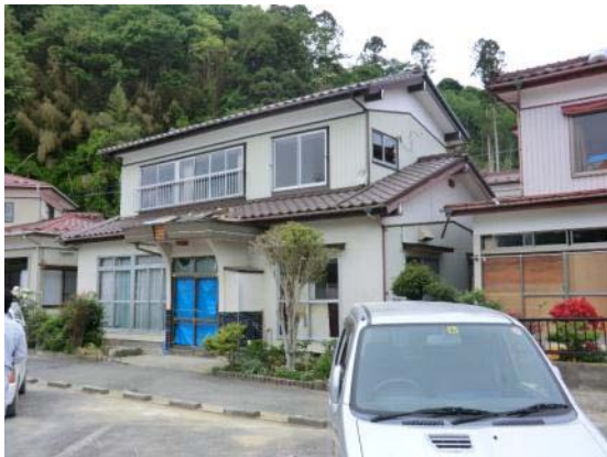
写真 C-13. 24 宮ヶ崎宮ヶ崎の浸水被害
