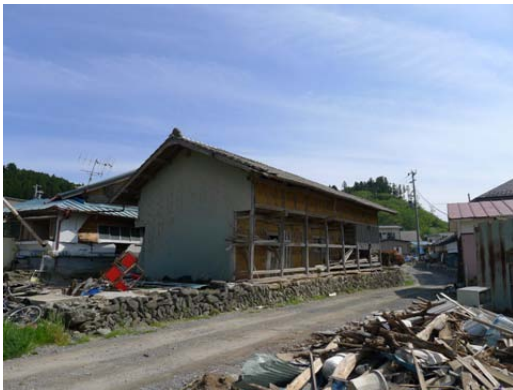
写真 C-10.17 残存する土壁による倉庫
