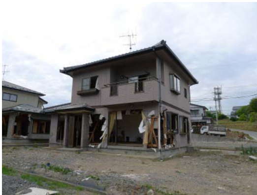
写真 C-17.5 残存する木造住宅
