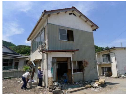
写真 C-9.2 浸水深測定建物
