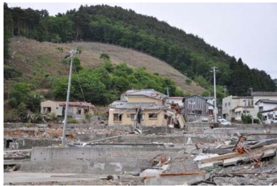
写真 C-13. 26 鷲神浜鷲神の流失跡と残存住宅
