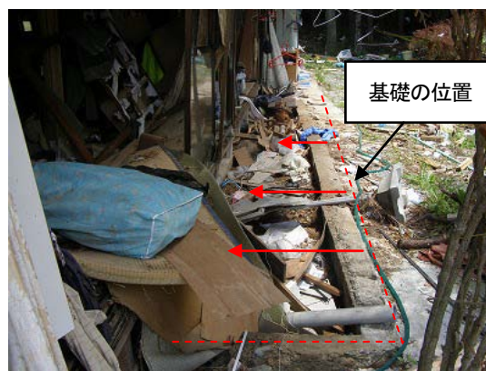
写真 C-15.4 住宅Aの上部構造の移動
