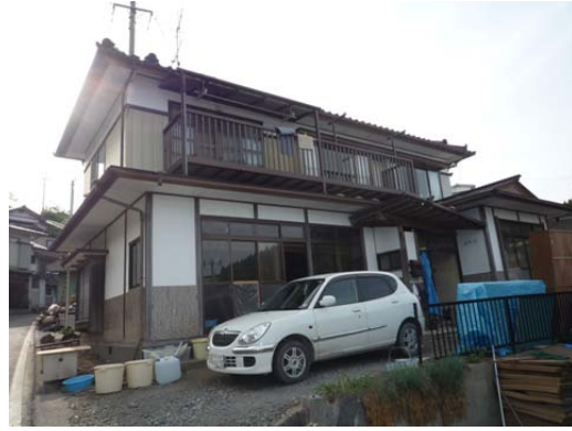
写真 C-12.4 浸水深 3.4 m の木造住宅
