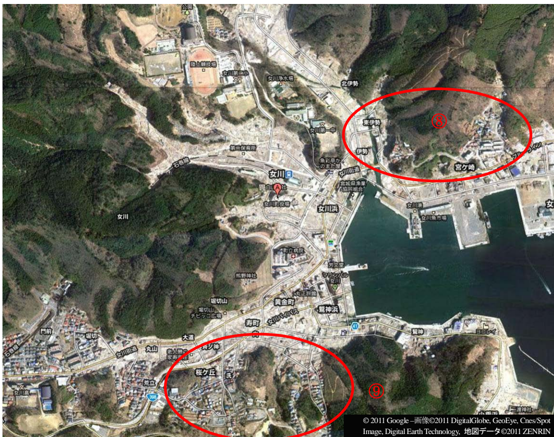
写真 C-13.4 女川町の被害調査地域（女川駅周辺）
