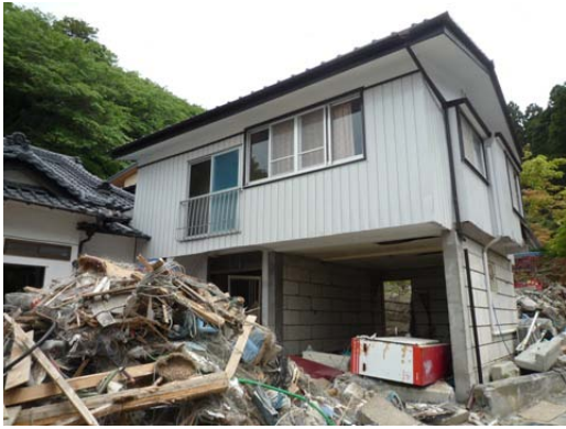
写真 C-20.11 1階部分を野蒜石と推測される 石材による組積造として 3.0mの浸水深に耐えた家屋
