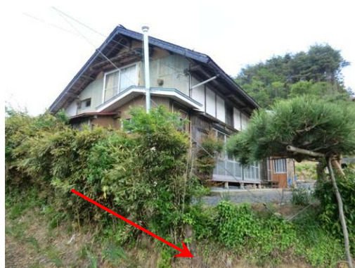
写真 C-7.15 M邸よりも高台に建つ木造住宅。外観上の被害はない。
