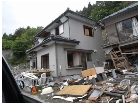
写真 C-3.4 流失境界付近の木造住宅の被害
