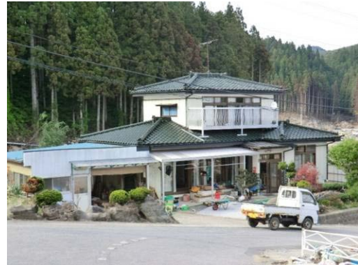
写真 C-13. 17 廻館地区の傾斜地に建つ木造住宅（1階天井まで浸水）
