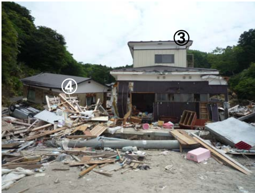
写真 C-20.5 流失した木造家屋 (④) と残存する木造家屋 (③)
