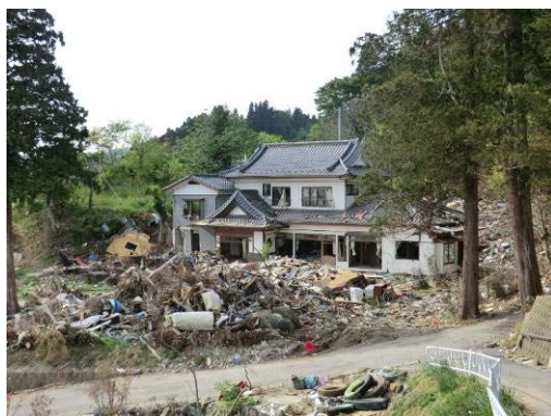
写真 C-13.14 城場地区の傾斜地に建つ木造住宅（2階中央の高さまで浸水）
