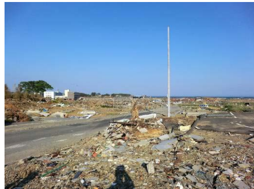
写真 C-7.32 波路上原牧付近の被害
