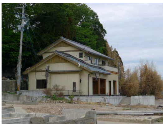
写真 C-18.3 残存する木造住宅
