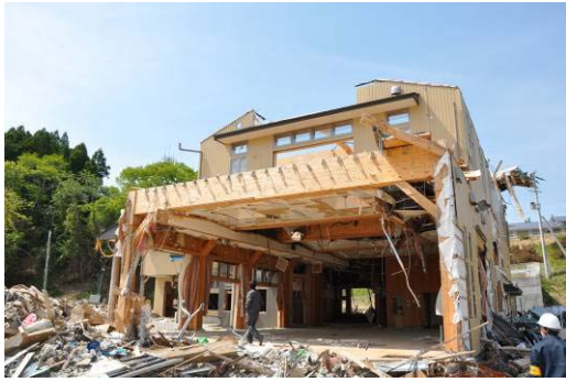
写真 C-13.9 残存する集成材フレーム構造
