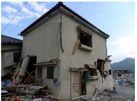
写真 C-4.7 残存した木造住宅
