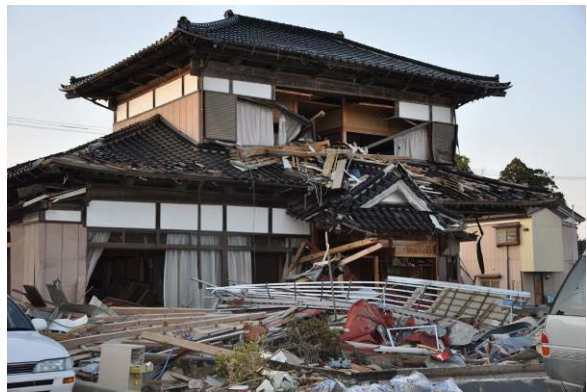
写真 C-7.30 漂流物により損傷したと考えられる木造住宅（本吉町野々下地区）
