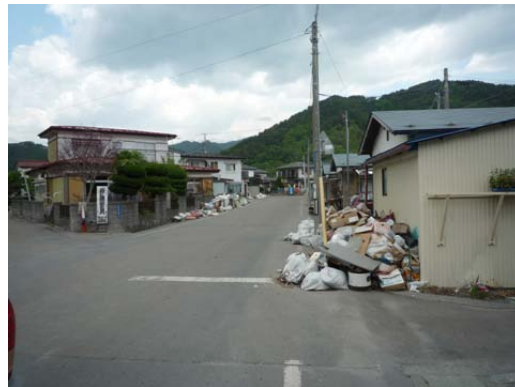
写真 C-2.4 第14地割北西部の概況
