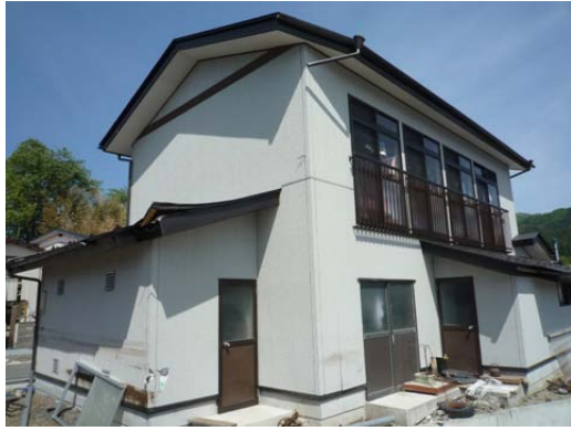
写真 C-10.3 赤碕町海岸付近で無被害の木造 (浸水深 7 m 以上)
