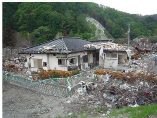
写真 C-2.6 第14地割南東部の入射方向先頭の木造家屋 (①)
