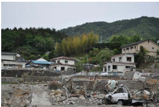
写真 C-13. 27 鷲神浜鷲神の流失跡と残存住宅
