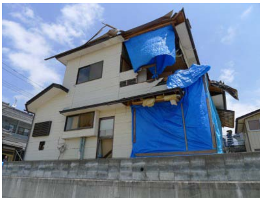
写真 C-14.5 残存する木造住宅
