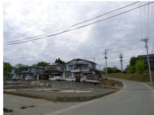
写真 C-17.6 残存する木造住宅
