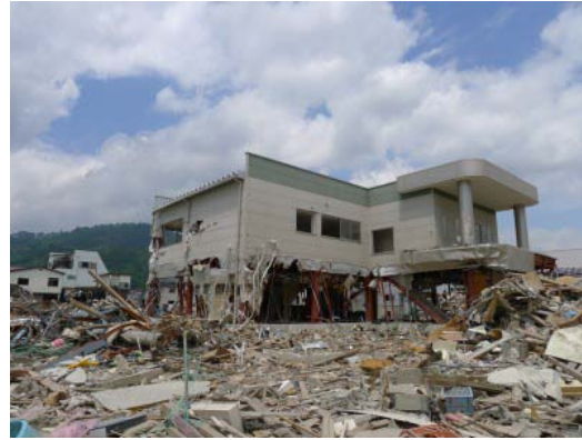
写真 C-14.2 残存する鉄骨造店舗
