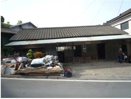
写真 C-12.3 軒まで浸水した平屋建て木造家屋
