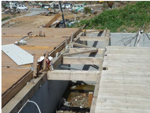
写真 C-10.11 写真 C-10.10 のホールダウン金物
