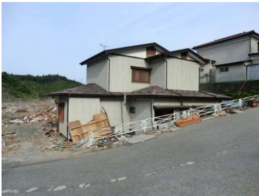
写真 C-13. 18 廻館地区の傾斜地に建つ木造住宅（写真 C-13. 17 よりもやや高い場所に建ち、1階の開口部上部まで浸水）
