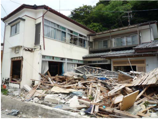
写真 C-20.9 一部損壊しながらも残存する 木造家屋 (⑥)
