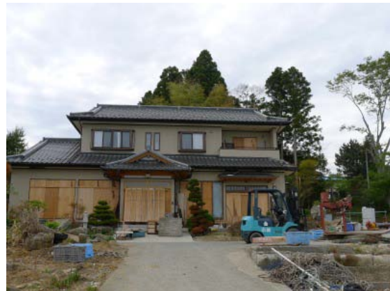
写真 C-18.2 残存する木造住宅
