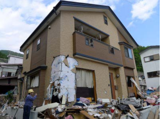
写真 C-4.8 残存した木造住宅
