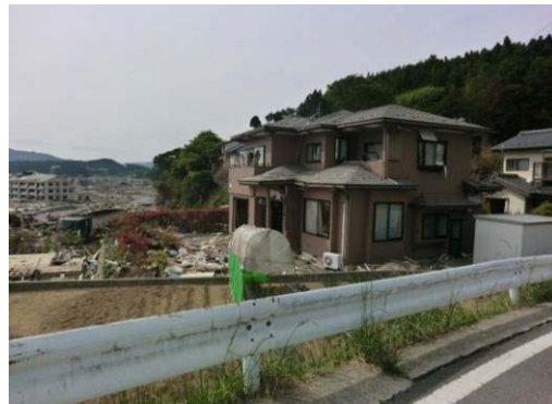
写真 C-13.11 写真 C-13.10 の左手前で、軒下まで浸水した木造住宅
