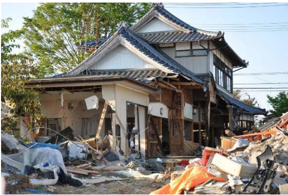
写真 C-7.31 道路南側の被害が甚大な住宅
