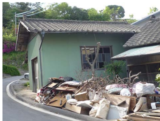
写真 C-12.2 浸水深 1.7m の倉庫
