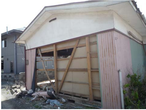
写真 C-10.15 写真 C-10.14 の筋かい
