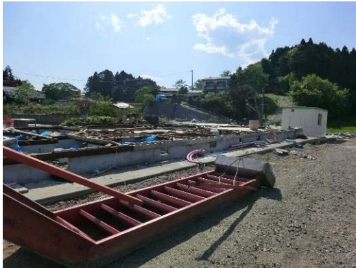
写真 C-7.20 流失した木造住宅 (本吉町山谷・日門地区)
