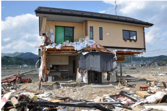
写真 C-7.12 残存する木造住宅 (本吉町津谷新明戸)
