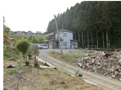
写真 C-13. 19 廻館地区の傾斜地に建つ木造住宅のうちの1棟（1階下部まで浸水）
