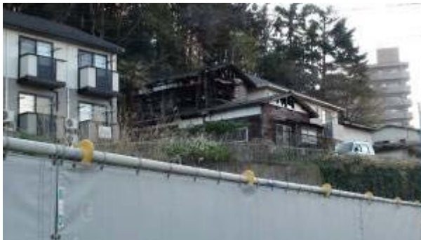
写真 7.2-7 仙台市太白区の住宅火災
