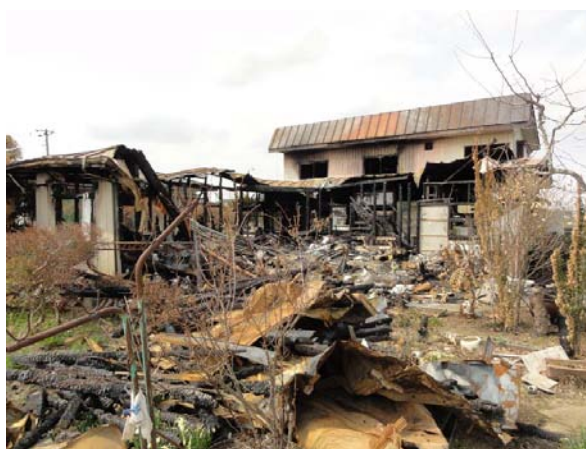
写真 7.2-5 奥州市水沢区小石田の火災
