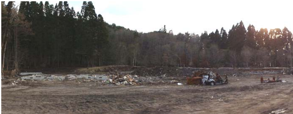
写真 7.3-2 火災現場全景 (火災現場東側の駐車場より撮影 (4月26日))
