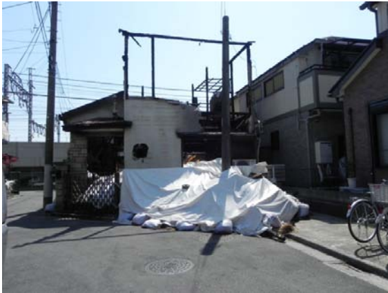
写真 7.2-22 火元建物外観(西側)
