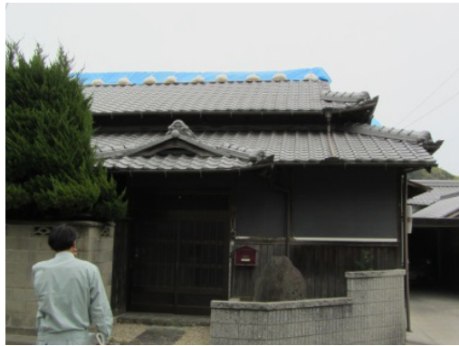
写真 6.31 棟の被害
