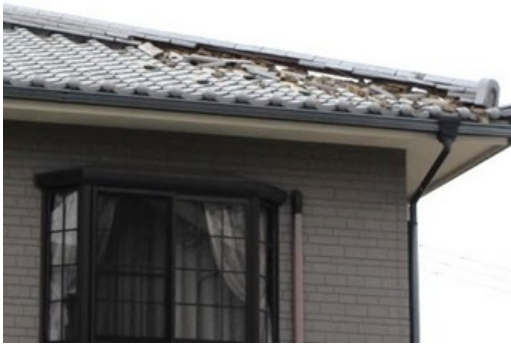
写真 6.37 瓦の被害
