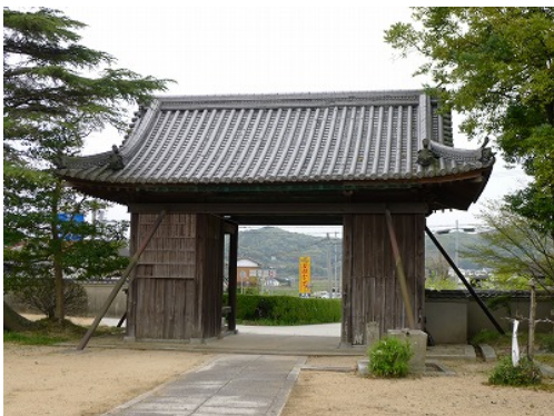
写真 6.32 鋼材により耐震補強された門 (大きな被害は見られない)
