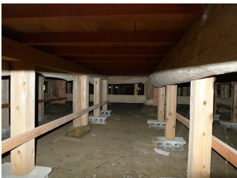
写真 6.34 本堂床下 (石場建ての柱と束)
