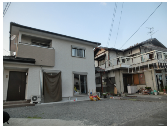
写真 5.5.11 被害軽微な比較的新しい家屋(左)
