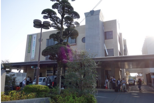
写真 5.4.1 益城町役場庁舎の全景
