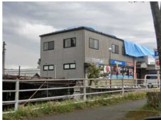
写真 5.4.2 屋根に被害を受けたと推測される 2 階建て店舗建築
