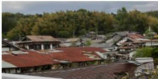
写真 5.6.2 屋根の被害が多い益城町小谷
