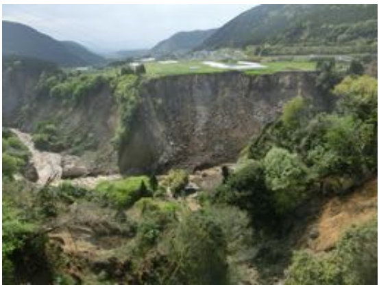
写真 5.3.7 黒川西岸の土砂崩落
