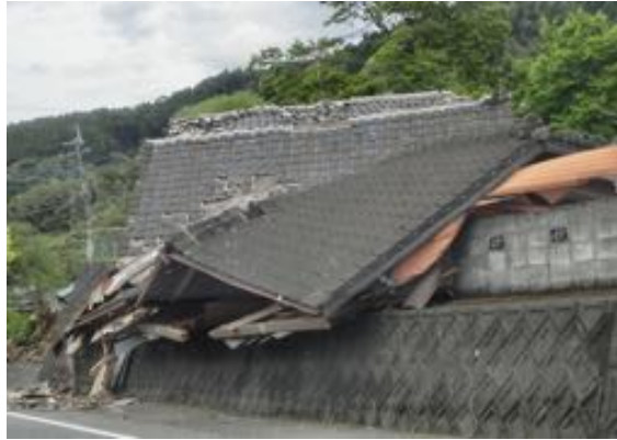
写真 5.5.4 倒壊した家屋
