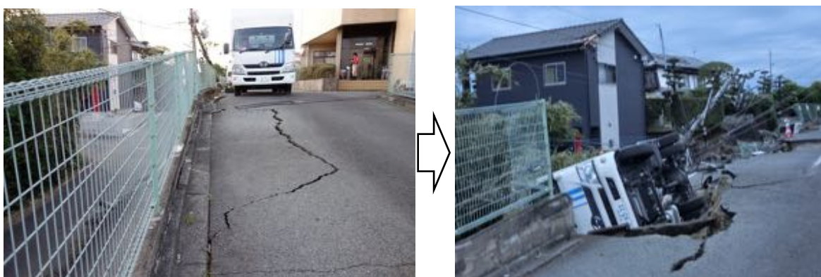
写真 6.1.3 敷地内の舗装のひび割れ（左：4/15）と地盤崩壊により転落した車両（右：4/16）
