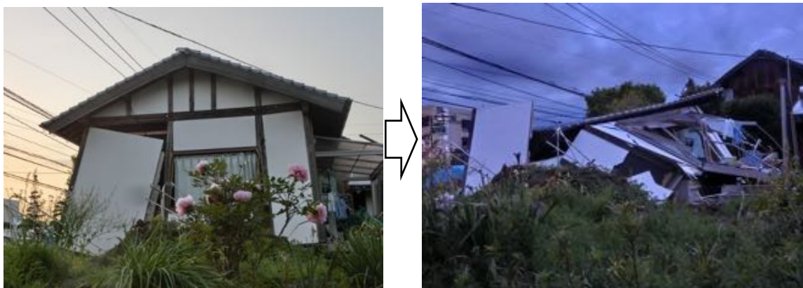
写真 6.2.2 壁が外れただけの家屋（左：4/15）が倒壊した（右：4/16）例
