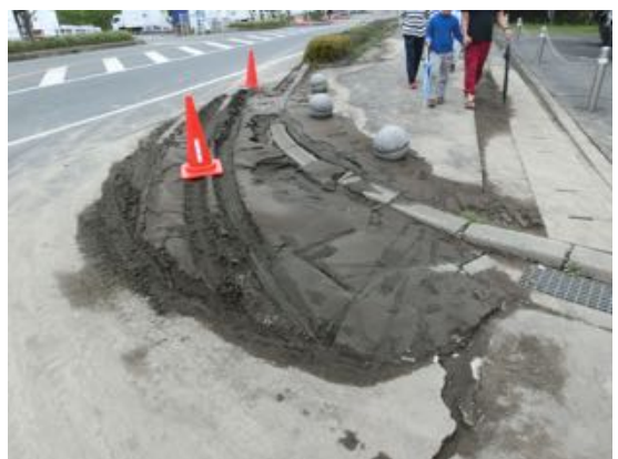
写真 5.7.6 液状化により噴出した大量の砂
