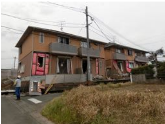
写真 5.7.11 地盤の影響を受け被害が大きな共同住宅
