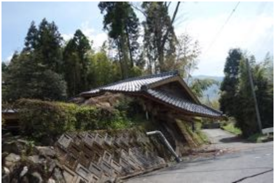
写真 5.3.3 倒壊して擁壁上から落ちそうな家屋
