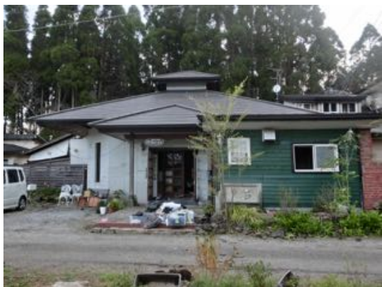
写真 5.1.1 宿泊施設の RC 造食堂棟
