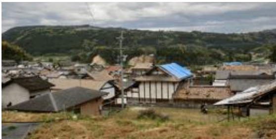
写真 5.6.1 屋根の被害が多い益城町小谷
