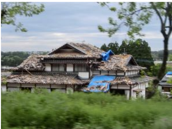
写真 5.5.1 屋根の被害が大きな入母屋
