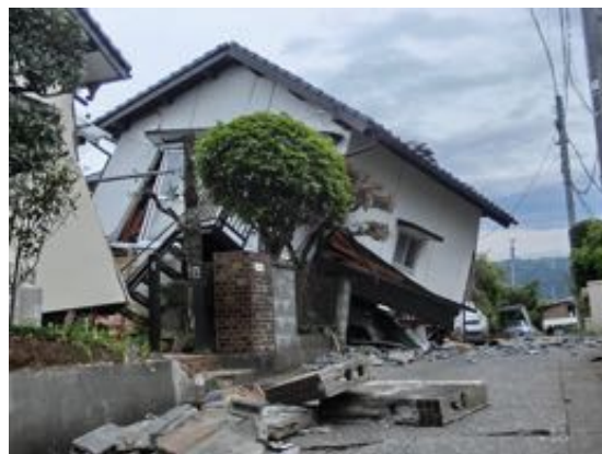
写真 5.7.10 木山地区の倒壊家屋
