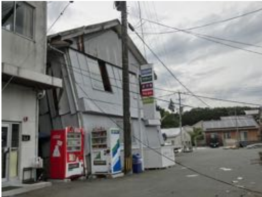
写真 5.6.6 残留変形の大きな事務所建築
