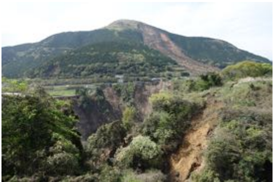
写真 5.3.5 阿蘇大橋上部の土砂崩れ痕
