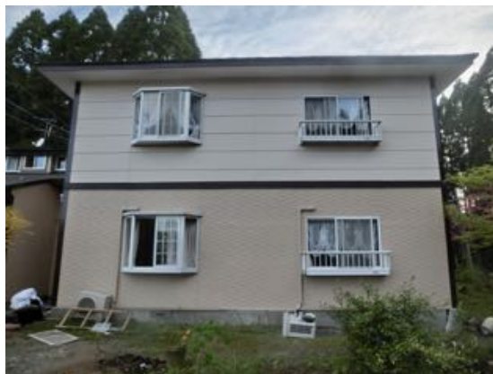
写真 5.1.2 宿泊施設の木造 2 階建ての宿泊棟
