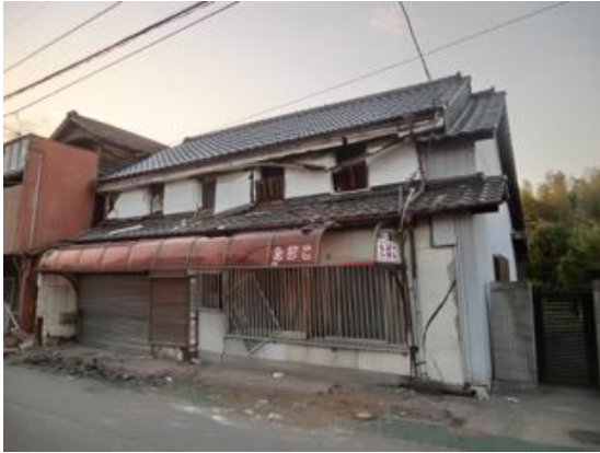
写真 6.2.3 残留変形が大きくなった店舗併用住宅（左：4/15、右：4/16）
