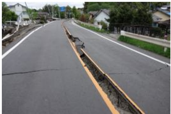
写真 5.7.4 アスファルト舗装に生じた割れ
