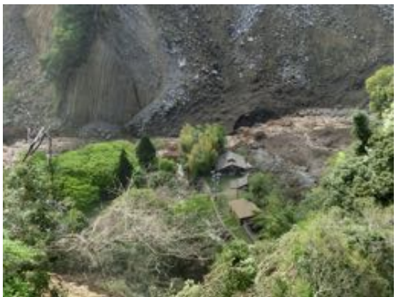
写真 5.3.8 土砂につぶされそうな建築物
