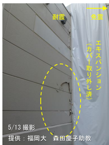
写真 5. 10. 3 エキスパンション部の破損と取り外されたカバー
