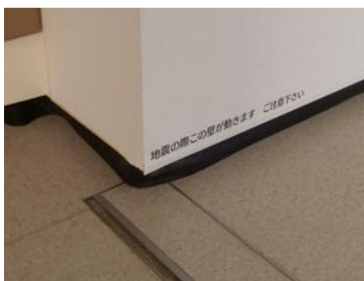
写真 5.1.9 建築物内部における免震表示（右図は左図囲みの表示内容の拡大）
