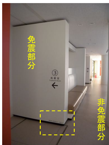
写真 5.1.9 建築物内部における免震表示（右図は左図囲みの表示内容の拡大）
