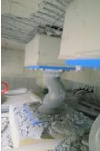
写真 5.3.3 鉛ダンパー取付け基部の被害（床スラブの破損）
