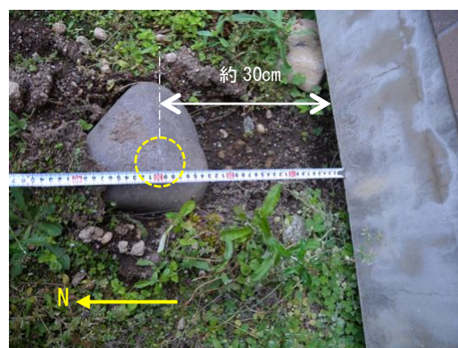
写真 5.7.2 免震層周囲の石の移動跡
