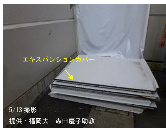
写真 5. 10. 3 エキスパンション部の破損と取り外されたカバー
