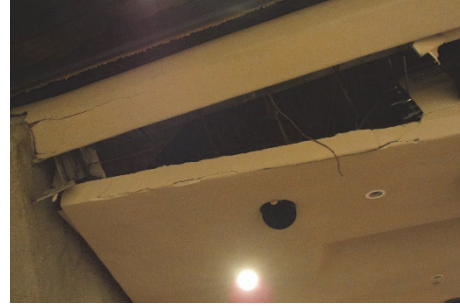
(j) 天井の立ち上げ部分((i)の上方見上げ)
