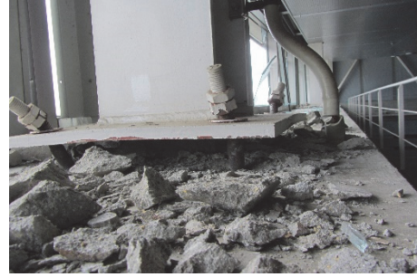
(j) 屋根支承部 (d ホール)
