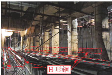
(m) 天井裏 多数のH形鋼が水平に配置されている。
