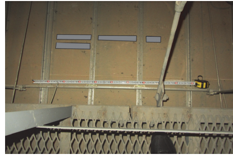
(b) 天井裏 (野縁ピッチ約 30cm)
