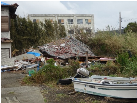
写真 4. 2. 34 倒壊した倉庫(被災後)
