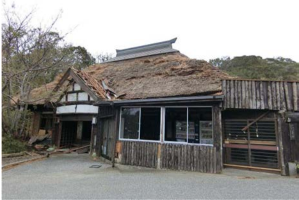
写真 4.3.54 茅葺き屋根の古民家の外観
