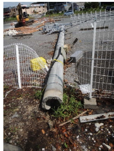
写真 4.2.8 電柱の折損
