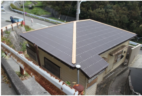
写真 5.1.45 応急的な処置をした住宅の屋根
