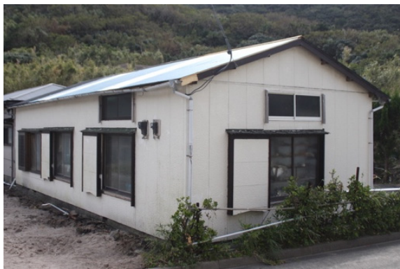
写真 5.1.32 屋根に被害を受けた住宅
