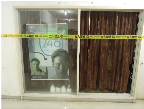
写真 3.8 第2庁舎地下1階中央部のガラス
