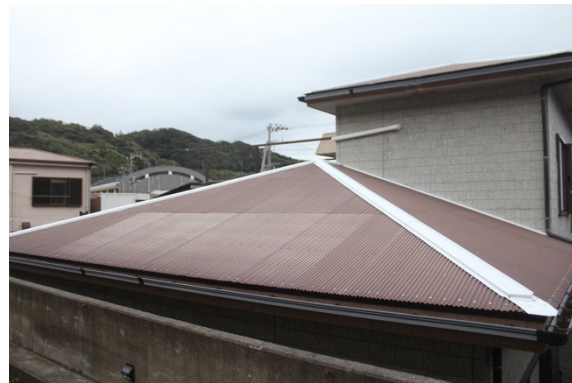
写真 5.1.34 補修された住宅の屋根
