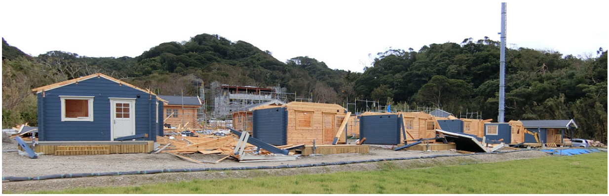
写真 4. 3. 58 建築途中の 12 棟のログハウスの被害状況
