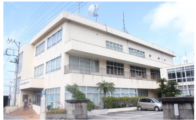
写真 5.2.3 新島村住民センターの屋上に設置されている風速計
