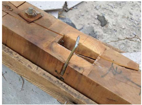
写真 4.1.23 木造倉庫のアンカーボルト と柱脚のかすがい
