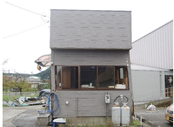
写真 4.1.10 小規模木造建築物の残留変形
