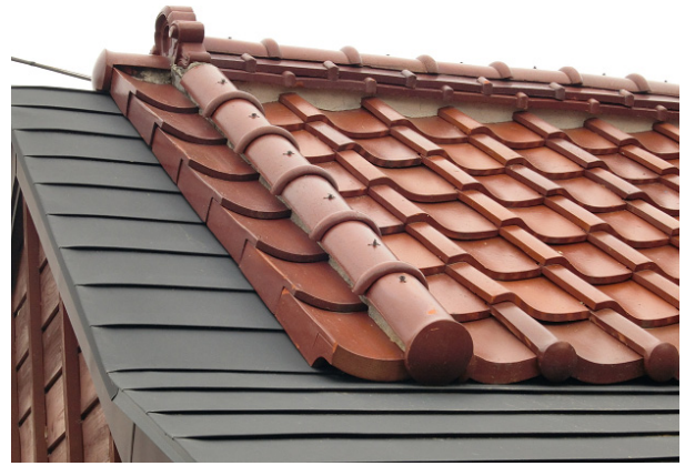
写真 4.3.35 最近改修したとみられる瓦屋根の棟 写真 4.3.36 緊結され、無被害であった隅棟部の瓦の脱落
