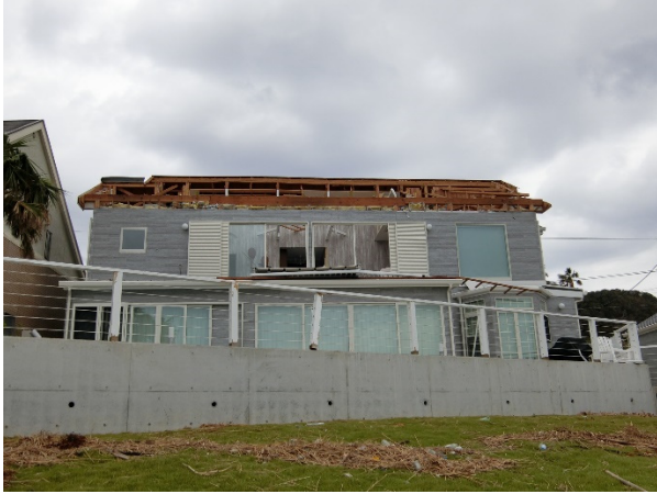
写真 4.3.72 屋根の飛散
