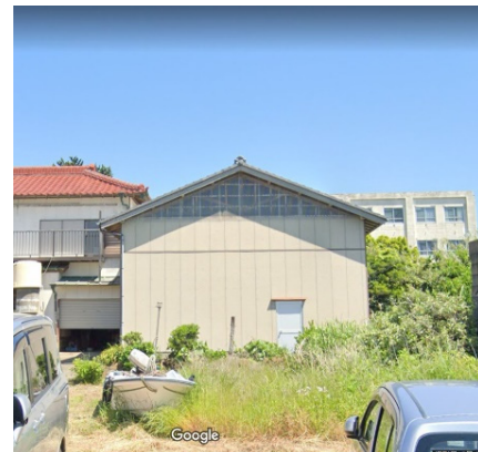
写真 4. 2. 35 被災前の状況 (Google ストリートビュー(2019年5月)より)
