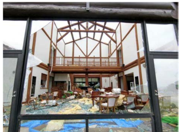
写真 4. 3. 51 宿泊施設 G の内部の状況
