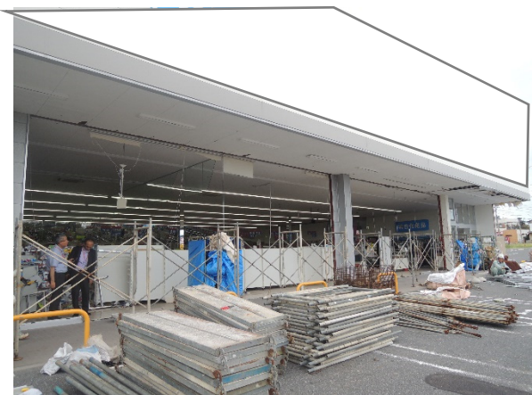
写真 4.3.9 脱落した建具の応急復旧に向けた準備状況
