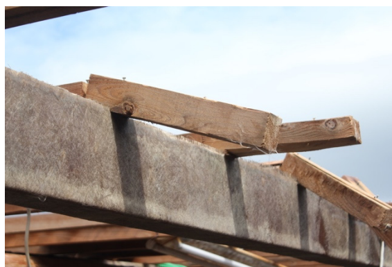
写真 5. 1. 13 木造の元造船所 B の FRP で覆われた横架材と垂木
