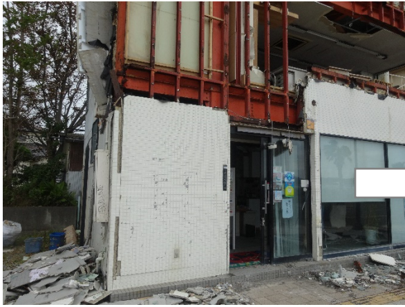
写真 4.3.5 外壁の脱落
