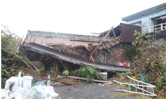
写真 5. 2. 24 倒壊した店舗 D
