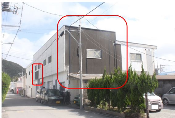
写真 5.2.8 住宅の外壁被害の応急的な補修
