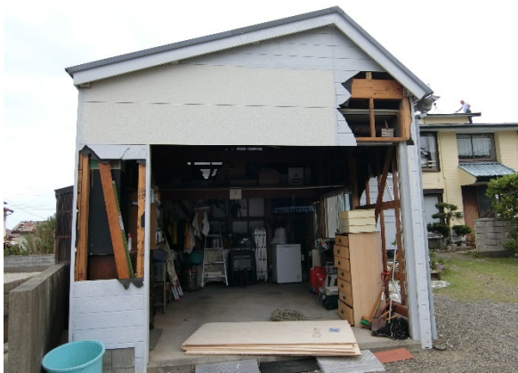
写真 4.3.37 外壁材が脱落した車庫
