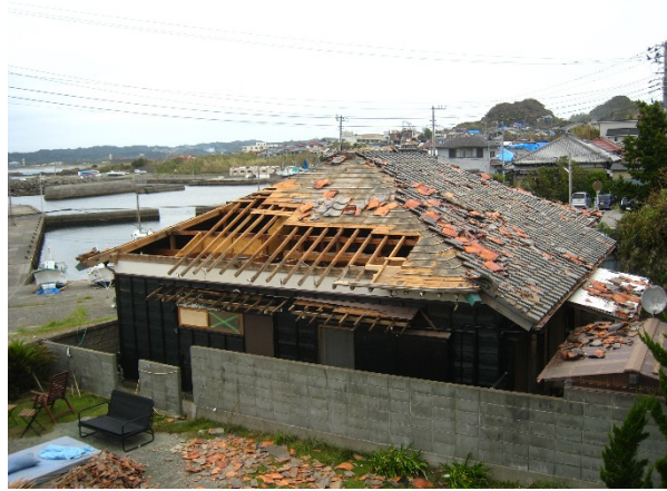
写真 4. 3. 45 野地板が飛散した木造住宅
