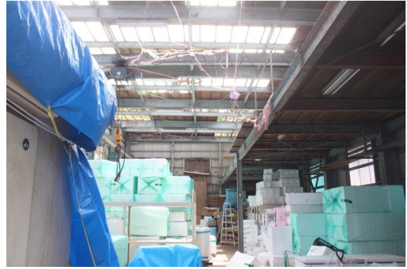
写真 5. 1. 15 鉄骨造の元造船所 C の被害
