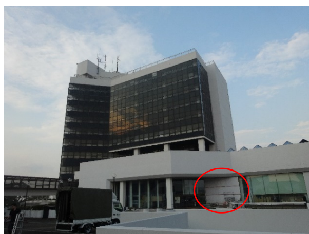
写真 3.1 第2庁舎の外観
