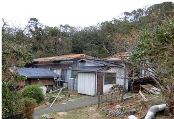
写真 4.3.56 写真 4.3.54 の住宅の東に隣接する 木造の宿泊施設 H
