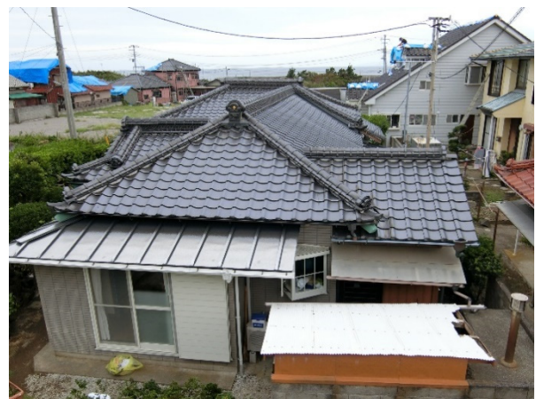
写真 4.3.34 無被害に見える瓦屋根(2)
