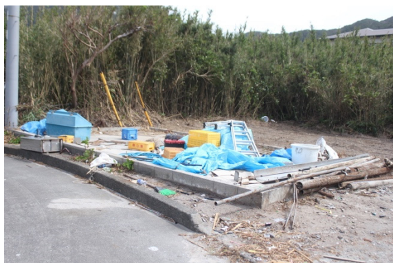
写真 5.1.35 倒壊した倉庫 A の跡地
