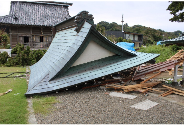
写真 4. 3. 48 倉庫の倒壊
