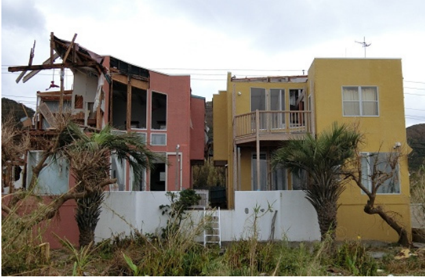
写真 4.3.61 海岸沿いに建つ 2 棟の木造住宅
