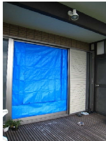
写真 4.3.75 写真 4.3.74 の 1 階の掃き出し開口
