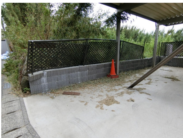
写真 4. 3. 27 3段積みブロック塀全体の様子
