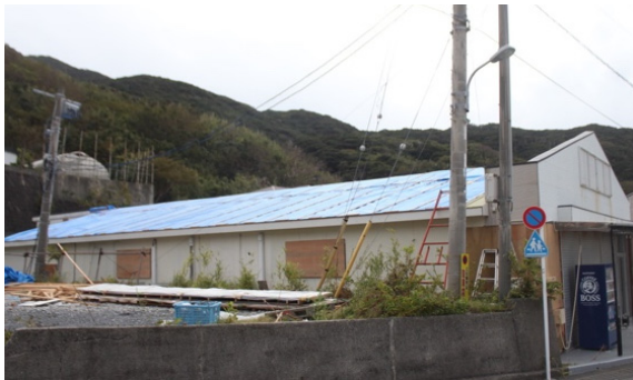
写真 5.1.23 ブルーシートで覆われた 店舗 A の屋根 (1)
