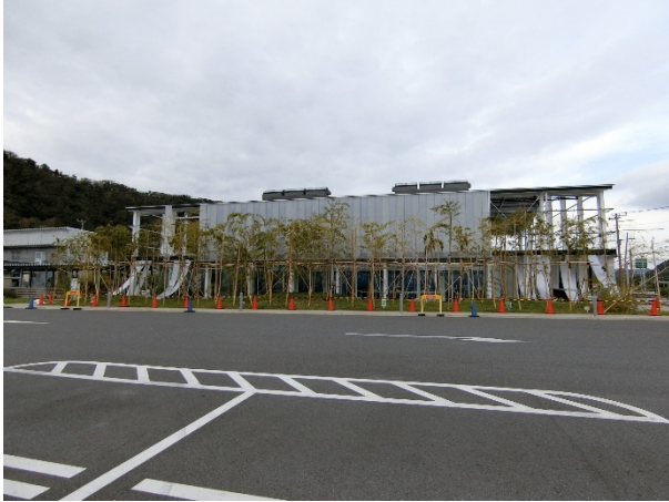
写真4.1.11 店舗Dの外観
