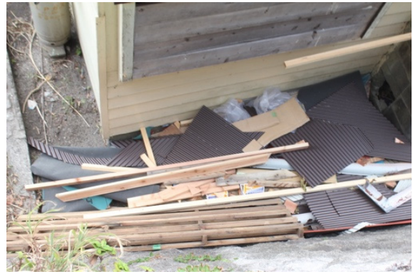
写真 5.1.46 飛散した屋根材
