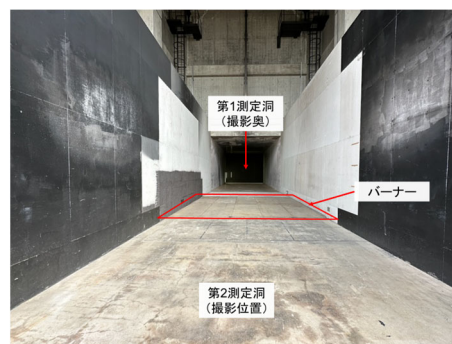
右：測定洞の床面の補修
