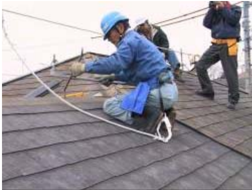
木造住宅における分別解体及び再資源化に関する実大実験
