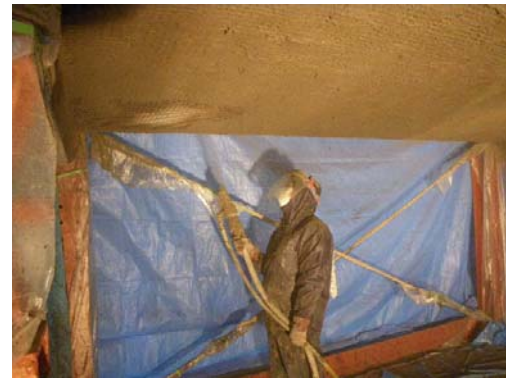
写真1 上げ裏部位への施工実験の状況
