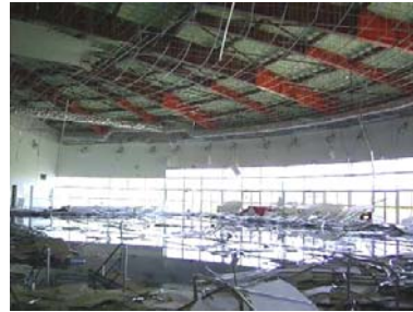
大規模天井の脱落 (平成 17 年宮城県沖地震)
