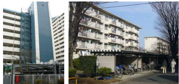
写真-1,2 サブテーマ1のモデル地区 (左：高層団地、右：中層団地)
