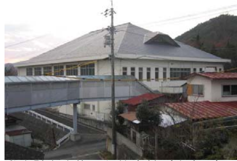
振動実験を実施した体育館（広島県）
