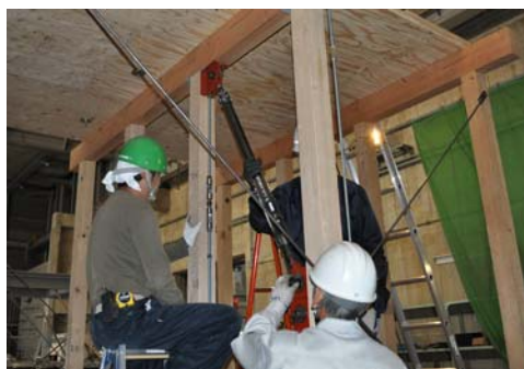
写真二 ダンパー取り付け作業の様子
