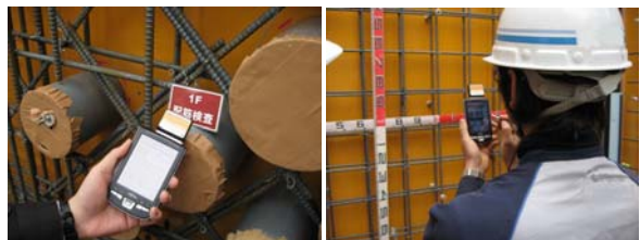
図6 RC造の実施工現場における検証実験 左：検査行為の認証を受けるためのIDをICタグから取得している様子。 右：PDAを使って検査を行っている様子。
