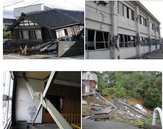
図1 各構造の地震被害例
