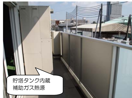
写真5 ソーラー給湯システム実用化製品設置例 (バルコニー内)
