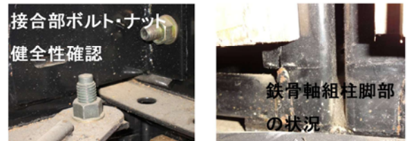
写真1 既存鉄骨系住宅の構造体の劣化に関する現地調査
