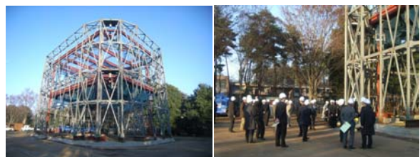
図5 鉄骨造の実大建物を用いた検証実験 左：検証実験に供した鉄骨造の躯体。 右：12月に開催した公開実験の様子。
