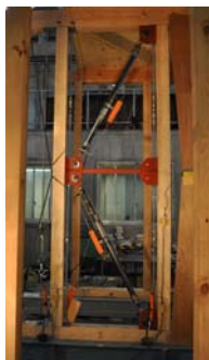
写真三 耐震ダンパー装置設置状況
