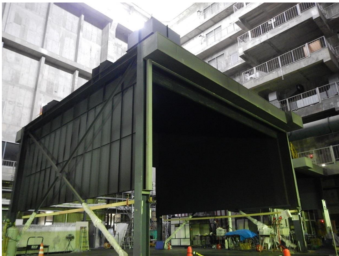
燃焼に伴う熱や煙・ガスを測定するための集煙フードが設置された火災実験場 (右奥は7階建ての煙実験場)
