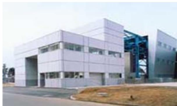
構造複合実験棟外観
