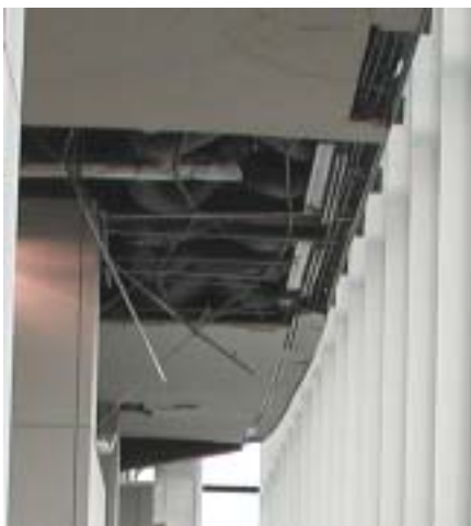
写真5 天井東端の被害状況
