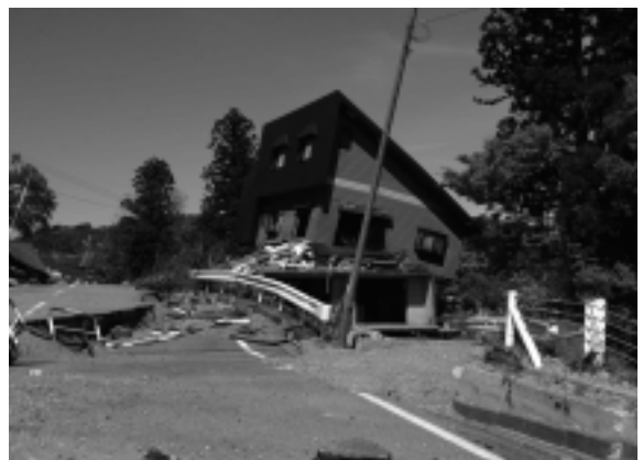
住宅の被災状況
