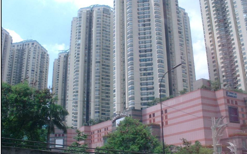
超高層ビルの建設が進むジャカルタ市（インドネシア）
