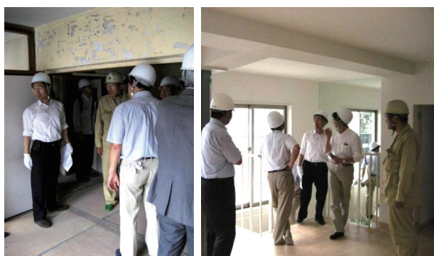
(a) 梁せい低減前 (b) 梁せい低減後 図1 梁下寸法の低さと梁せい低減による効果
