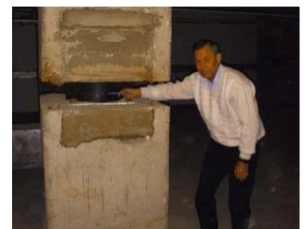
積層ゴムを用いた免震改修
