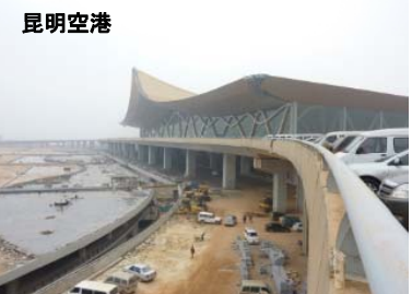
世界最大規模の免震建物である昆明空港(1180基の免震装置、108基のオイルダンパー)と振動台模型
