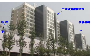
地下鉄の上の人工地盤上の免震建物 独自の3次元積層ゴム支承を使用
