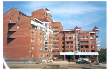
ロッキング柱を用いたイルクーツクの免震建物
