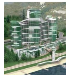
28階建て(建設中)
