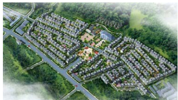
大規模な免震住宅群(云南 安晓文) 94棟(4-6階建て), 床面積280,000 m 2
