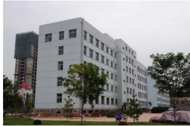
四川大地震後の学校の免震補強(山西省忻州市)すでに24棟が完成
