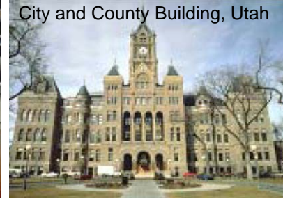
世界で最初の免震補強(1989)
