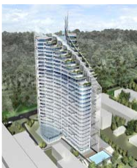
27階建て(建設中)
