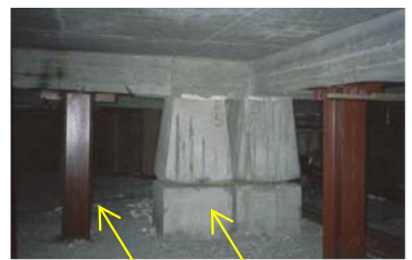
鋼材ダンパー ロッキング柱
