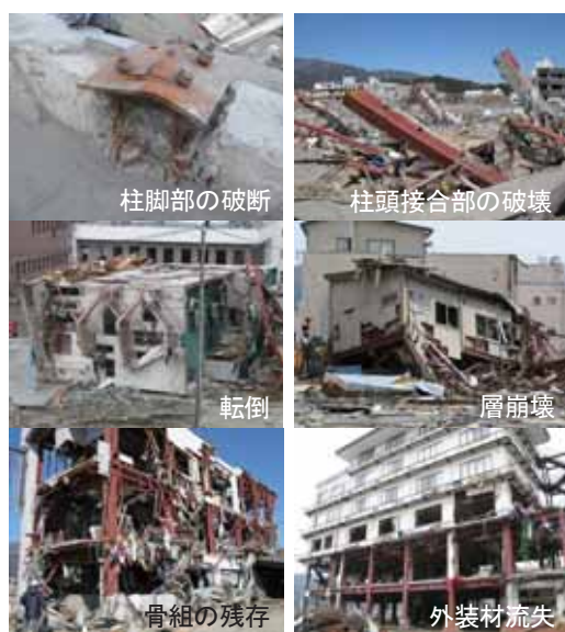
(図2) 鉄骨造建築物の被害
