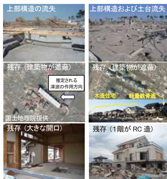
(図3) 木造建築物の被害
