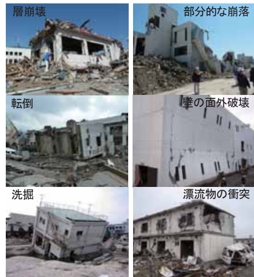
(図1) 鉄筋コンクリート造建築物の被害
