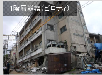
大きな被害を受けた旧耐震基準によるRC造建築物
