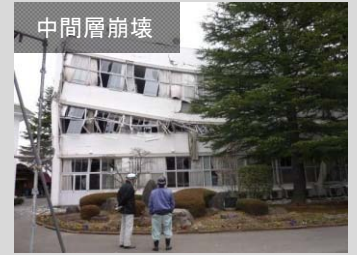
大きな被害を受けた旧耐震基準によるRC造建築物
