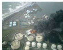
図 2.1 2003年十勝沖地震で発生した長周期地震動による苫小牧の石油タンク火災 左は建研省消防研究センター提供のタンク被災状況の航空写真。右は2003年十勝沖地震の震央(星印)や震源域(黒格子)と苫小牧の位置関係を示した地図 (Koketsu et al., 2005)。
