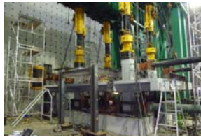
RC造部分架構実験
