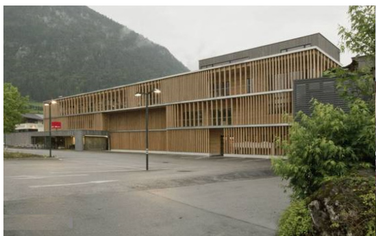
写真4 事務所建物 (Office Building "Meiberger" in Lofer, KLH のHPより)
