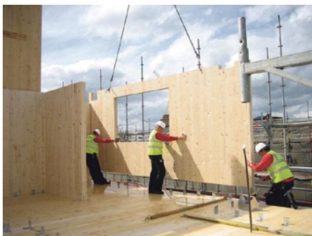
写真7 CLT構造による建物の施工
