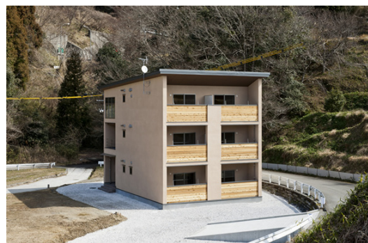
写真6 国内のCLT構造による建物 (高知おとよ製材㈱の社員寮, 銘建工業㈱のHPより)
