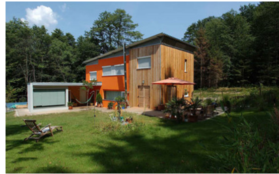
写真5 戸建住宅 (Family house in Graz, KLH の HP より)
