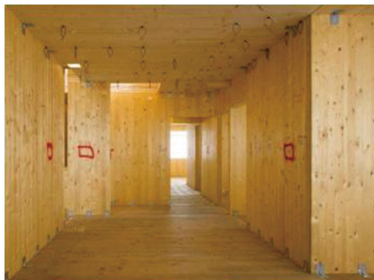
(3) CLT パネルによる工法 (murray-grove) 2)
