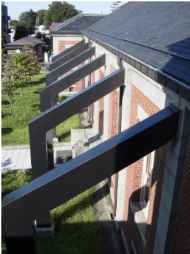
図-4 内部空間の価値を守るため内部からの補強を避け、外部にバットレスを新設することにより耐震補強を施した。文化財建造物としては外部に異物が露出するやりかたはそれまでは問題外とされていた。バットレスのデザインの基本方針は、①本体と素材を変え後補であることを明確にする。②本体との接触面をなるべく減らす。③本体と競合させないよう形を単純化させる、とした。右図は「重要文化財山形県旧県庁及び県会議事堂保存修理工事報告書」より
