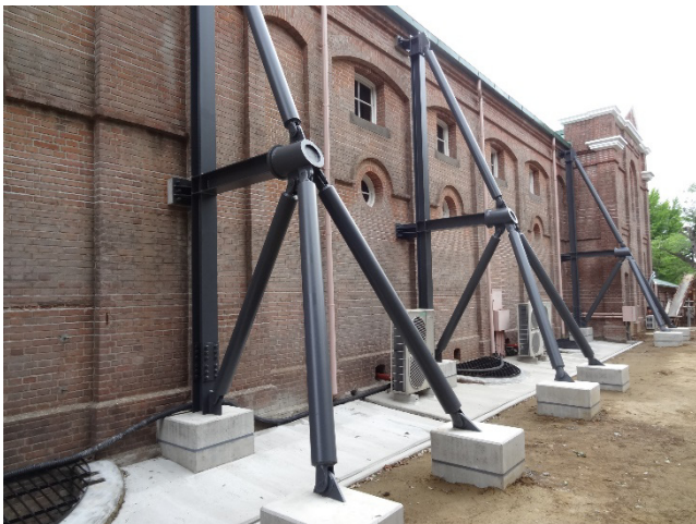
写真-6 重要文化財 シャトーカミヤ旧醸造施設醱酵室背面の鉄骨バットレス補強。ここでは丸形鋼管、接合部の形状やその色合い、テクスチャなど、補強材のデザイン性が追求された
