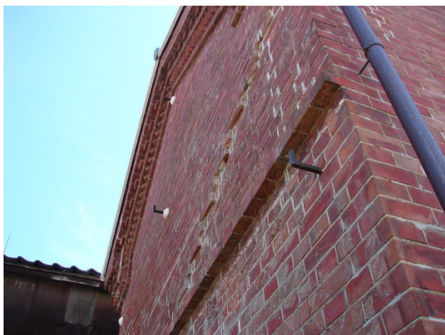
写真-7 茨城県内の指定外の某煉瓦造建造物。鉄骨フレームとステンレスピン補強を施した。地震によりずれた面はそのまま固めた。この建物にとって震災を受けたことも歴史のひとつとして刻んでいる
