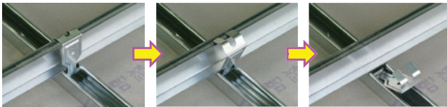
写真4 クリップの外れ
