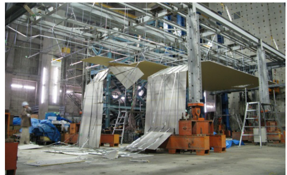
写真 5 クリップの外れによる天井面の落下 (実験結果)
