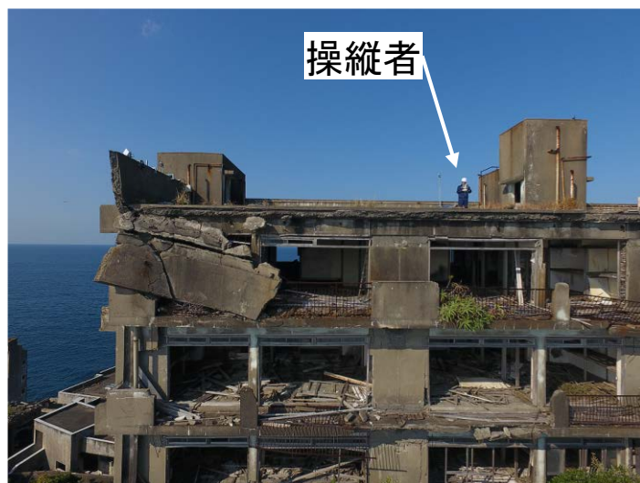
④外壁・パラペット破損の状況(端島3号棟)
