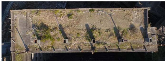
①屋上植栽の状況(端島16号棟)
