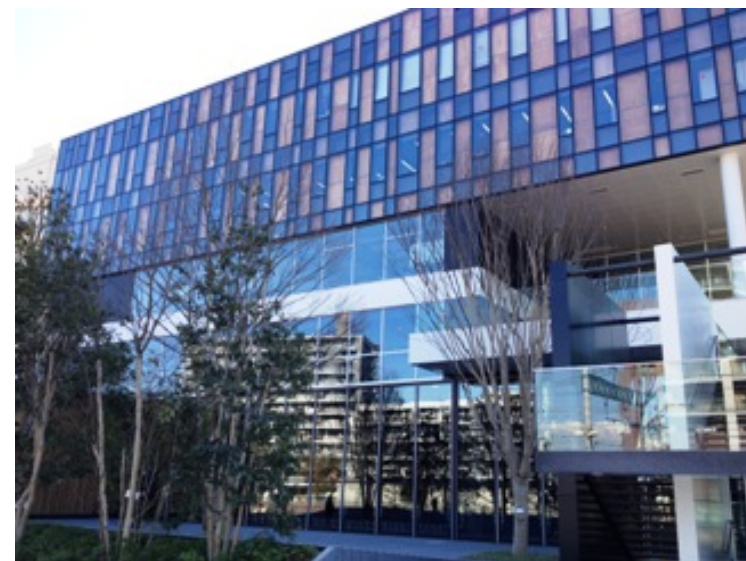
写真2 東部地域振興ふれあい拠点施設 1～4階をS造、5,6階を1時間耐火木造
