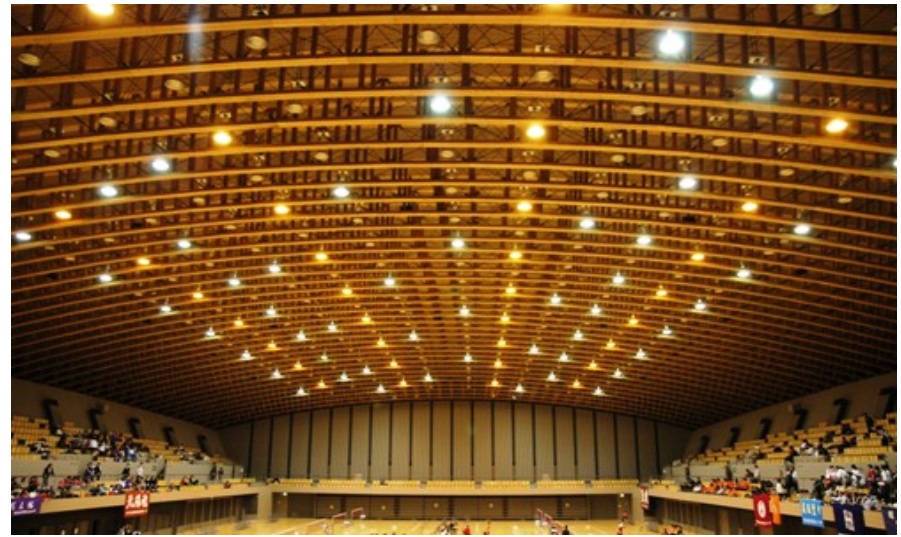
写真4 所沢市市民体育館 アリーナ80m×42m、天井最高部18メートル、最大67mのスパン
