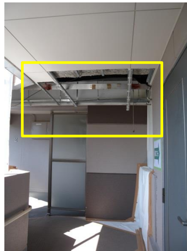
渡り廊下の天井材の脱落
