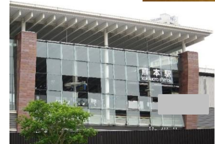
大判ガラス(DPG工法)の落下
