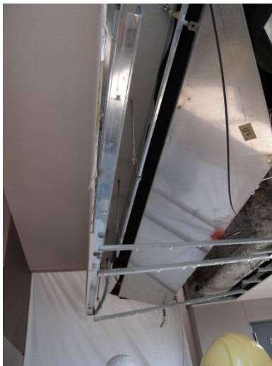
渡り廊下の天井材の脱落
