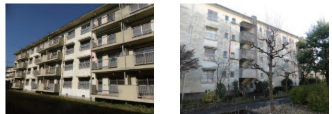
写真 1 調査対象建築物の外観
