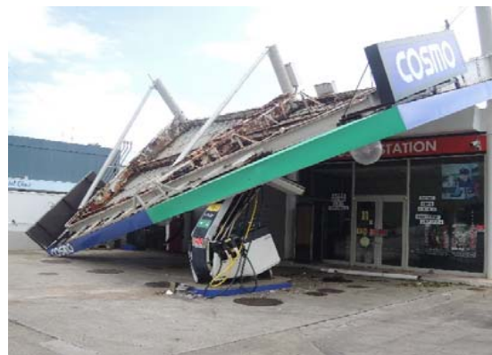
図17 ガソリンスタンドのキャンピの落下(館山市)
