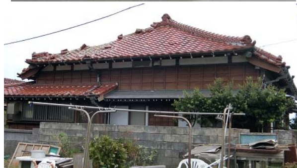
図22 野地板が飛散した木造住宅 (館山市)
