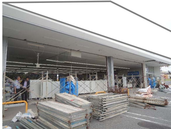
図37 脱落した建具の応急復旧に向けた準備(館山市)
