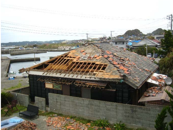
図22 野地板が飛散した木造住宅 (館山市)
