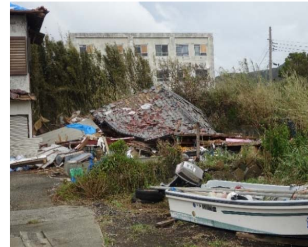
図6 木造倉庫の倒壊(南房総市)
