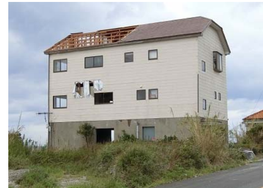
図21 屋根が飛散した海岸沿いの混構造3階建て住宅(館山市)
