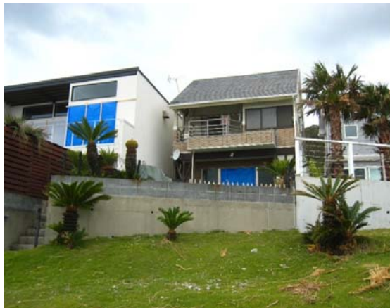
図19 図18の隣家の状況(館山市) 図18の西に隣接する住宅(図19)は、1階の掃き出し窓が割れたものの屋根は飛ばされなかった。1階の掃き出し開口は雨戸を閉めていたが、風圧力により雨戸が変形し窓ガラスが破損したとのことである。
