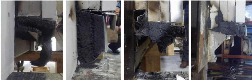
写真13 燃焼試験後の加熱膨張材の状況
