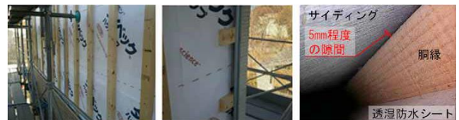
写真 4 胴縁およびサイディングの施工状況
