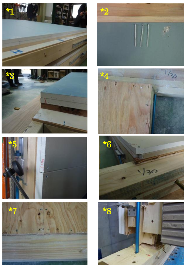
写真6 各部の損傷状況 (数字は表9中の数字の損傷状況)
