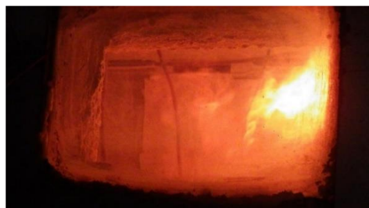
写真11 炉内における燃焼状況
