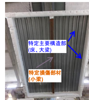
合成床の鉄骨小梁
