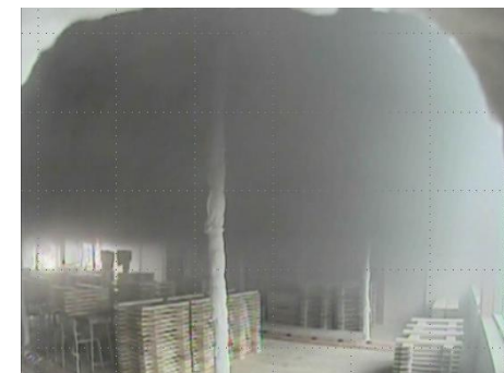
外壁開口部からの煙進入
