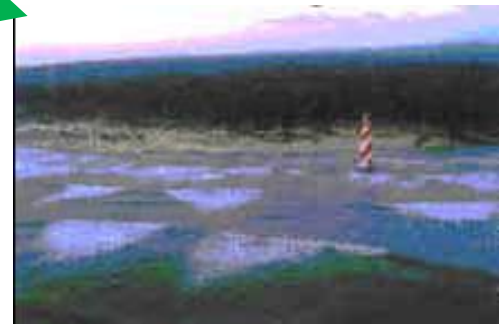
約3 m 沈降した 灯台
