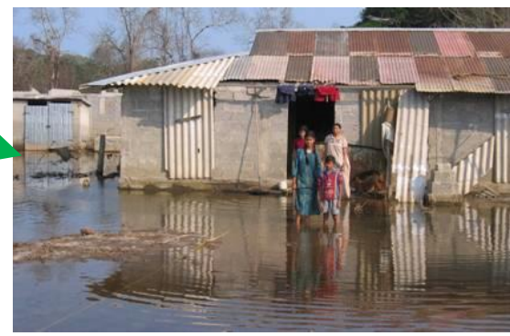
沈降による浸水 (Port Blair)
