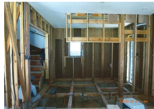
床材・下地材全面交換
