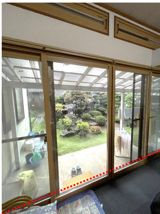
高断熱の内窓改修
