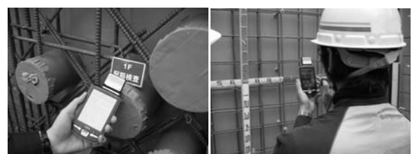
図 5 RC 造の実施工現場における検証実験
