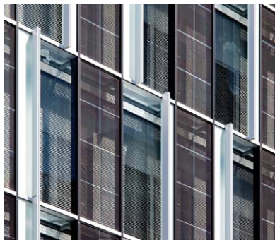
ダブルスキンカーテンウォール + 透過型太陽光発電パネル
