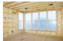
天井・壁等の断熱改修工事
