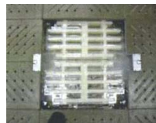
床下に設置された潜熱蓄熱材
