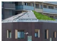
太陽光パネル
