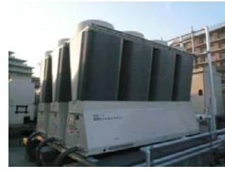
・高効率空冷モジュールチラー(COP6.3(散水時))
