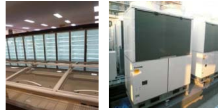
・高効率空冷モジュールチラー(COP6.3(散水時))
