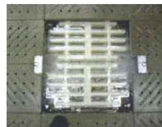
床下に設置された潜熱蓄熱材
