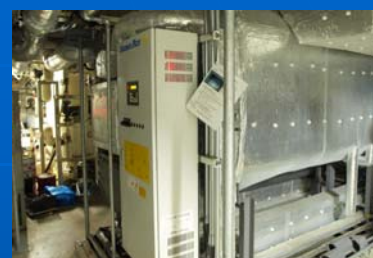
図: 改修・最適化した高効率熱源機器
