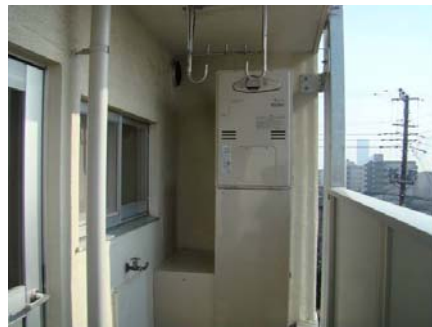
補助熱源機+貯湯タンク
