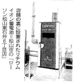
店舗の裏に設置されたリチウムイオン蓄電池。松山市の「ローソン 松山東石井6丁目店」
