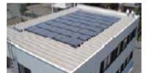
太陽光発電システム
