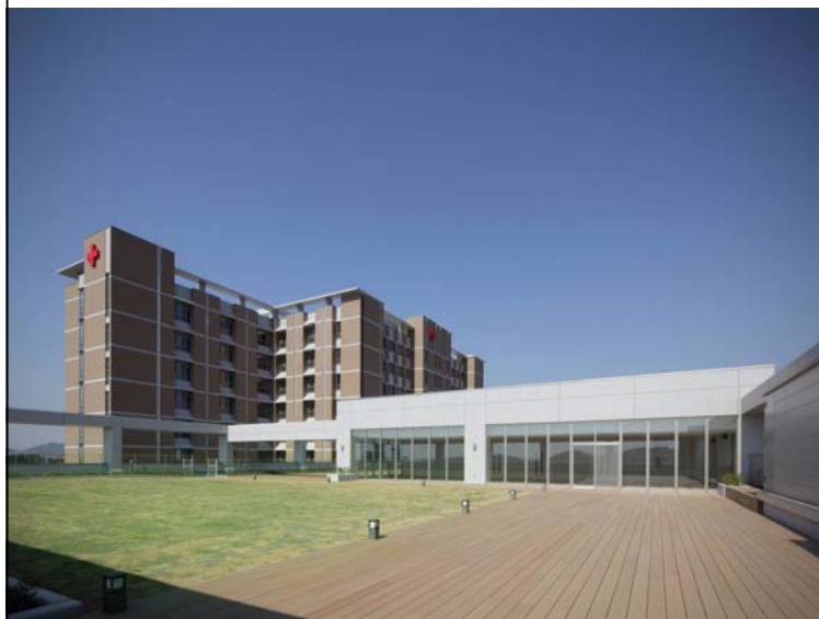
職員食堂から見える屋上庭園
