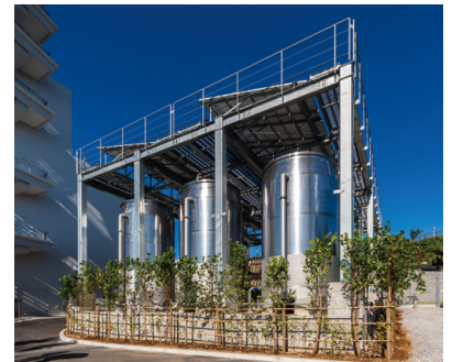
デシカント外調機により、効率よく除湿し井水で冷却。デシカントの再生には太陽熱を用いる。
