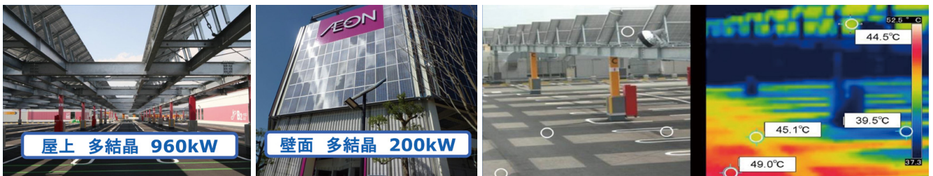
壁面と屋上に国内商業施設最大級計7,956㎡のソーラーパネルを設置。屋上では駐車場の遮熱効果も大きい。
