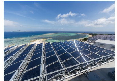
デシカント外調機により、効率よく除湿し井水で冷却。デシカントの再生には太陽熱を用いる。
