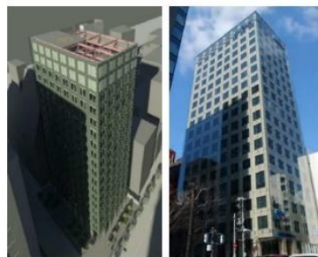
a) シミュレーション b) 完成時のビル影の様子 隣接建屋のビル影の影響
