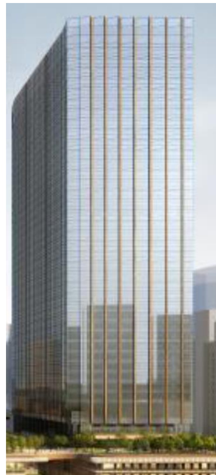
外壁太陽光パネル（スパンドレル部）
